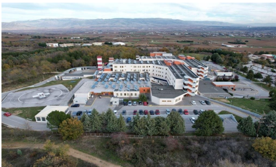
Εικόνα 6 – Μποδοσάκειο, Πράσινο Νοσοκομείο Πτολεμαΐδας
