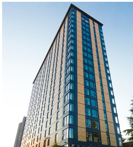
Εικόνα 31: Brock Commons Tallwood House
