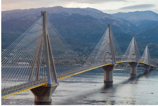
Εικόνα 29: Γέφυρα Ριο Αντιριο
