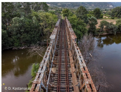
Εικόνα 11: Σιδηροδρομική Γέφυρα με Ξύλο
