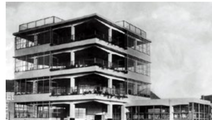
Εικόνα 1: Σχολείο υπαιθριόφιλου τύπου, Άμστερνταμ, Ολλανδία, Johannes Duiker, 1930
