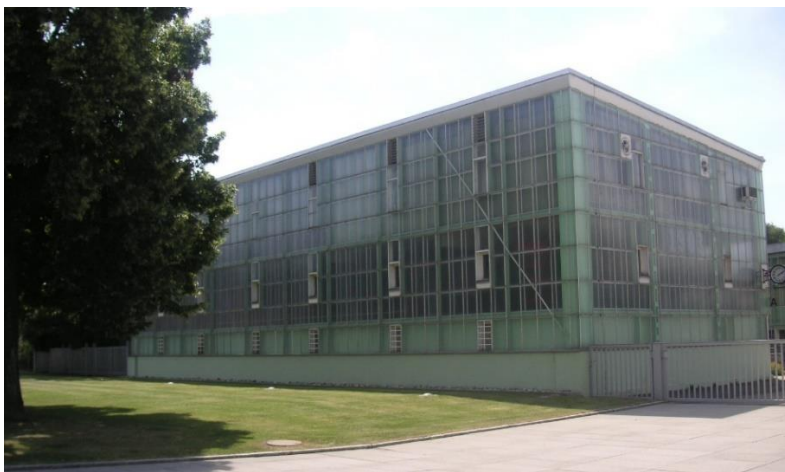
Εικόνα 28 Εργοστάσιο Steiff, Geingen, Γερμανία
