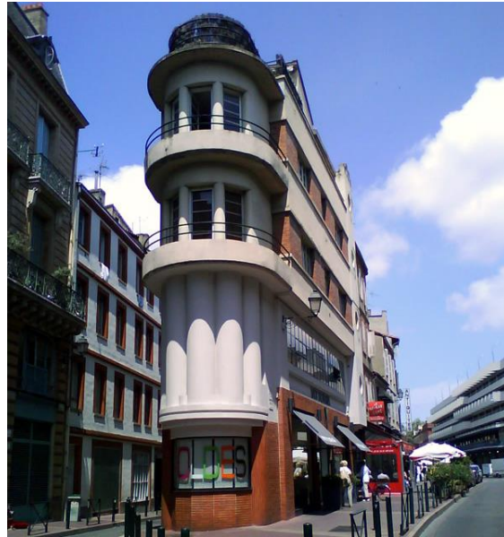
Εικόνα18. «Immeuble Benjamin», Τουλούζ, Γαλλία.
