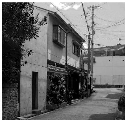
εικ.16: Η όψη της κατοικίας, γίνεται αντιληπτή η απουσία ανοιγμάτων.
