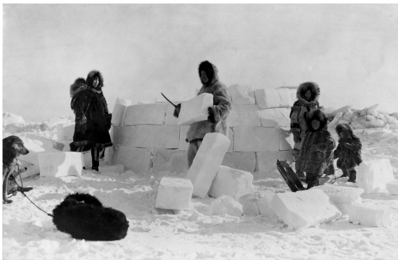
εικ.2 : Κατασκευή ιγλού (χειμερινή κατοικία των Εσκιμώων), 1924.
