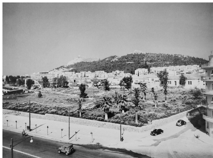
εικ.5: Το οικόπεδο επί της οδού Βασ. Σοφίας.
