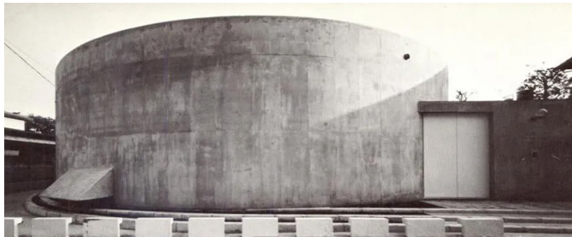
εικ.18: Η πρόσοψη της κατοικίας, διακρίνεται η απουσία των ανοιγμάτων.
