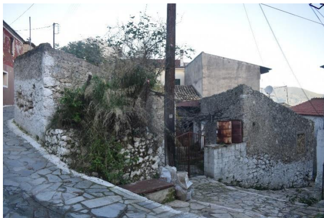
Άγιος Μαθαίος, Εξωτερική άποψη συγκροτήματος
