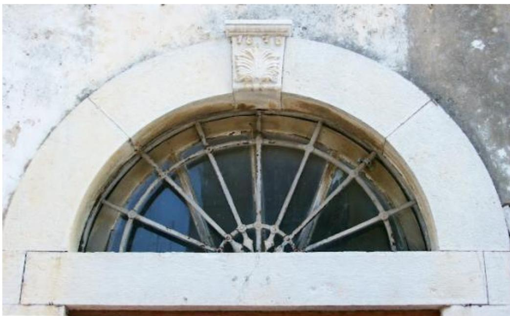
**Εικόνα XXII:** Τοξωτό υπέρθυρο κεντρικής εισόδου 1876 στην συμβολή οδών Παντελή Καρασεβδά και Ομήρου. Το κλειδί είναι σκαλιστό και έχει τη μορφή αναδιπλούμενης περγαμηνής, η οποία φέρει απλής μορφής ανθέμιο πάνω από το οποίο διαβάζεται η χρονολογία κατασκευής του κτίσματος «1876».
