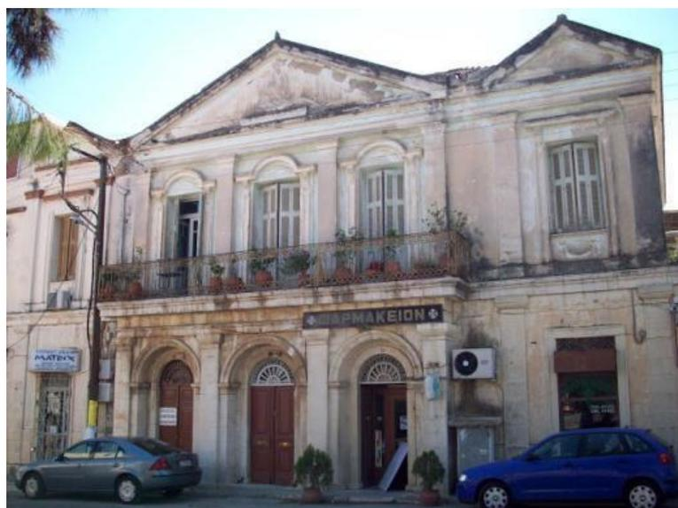
**Εικόνα IV: Όψη με ιδιαίτερο μορφολογικό ενδιαφέρον και απόλυτη συμμετρία. Αετώματα στέφουν τα τρία τμήματα της όψης, τα ανοίγματα του κέντρου είναι πόρτες που πλαισιώνονται δεξιά και αριστερά με παράθυρα. Παραστάδες χωρίζουν τα ανοίγματα μεταξύ τους και στους δυο ορόφους. Οι ποδιές των δυο παραθύρων φέρουν ως διακόσμηση κορδέλα με ανθέμια. Οικία Αργύνης Παπαδημητρίου στην οδό Βασιλέως Κωνσταντίνου.**
