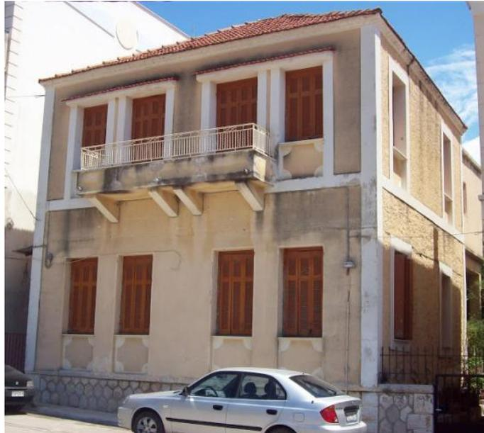
**Εικόνα VII:**Λιθόκτιστο κτίριο με επιμελημένη λιθοδομή, πέτρινη βάση και μαρμάρινο εξώστη. Τα ανοίγματα του ισογείου είναι παράθυρα τα οποία στην ποδιά φέρουν διακόσμηση γεωμετρικού σχήματος αντίστοιχη με αυτή του ορόφου ενώ στο πάνω μέρος έχουν πλαίσια σε προεξοχή καθώς και γείσωμα με κεραμίδια για την προστασία από τα νερά της βροχής. Οικία Μιλεούνη Νικήτα πλατεία Αγίου Νικολάου. Το κτίριο έχει δεχτεί πολλές νεότερες επεμβάσεις
