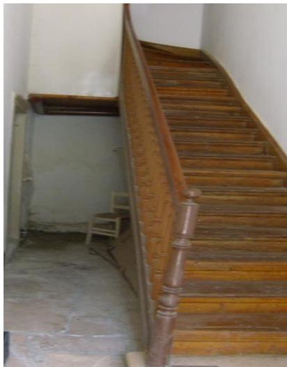
**Εικόνα II: Εσωτερικό σπιτιού. Το δάπεδο του κλιμακοστασίου έχει επιστρωθεί με σχιστολιθικές πλάκες ακανόνιστες. Οικία ιδιοκτησίας Δήμου Αστακού στη συμβολή των οδών Παντελή Καρασεβδά και Ομήρου.**
