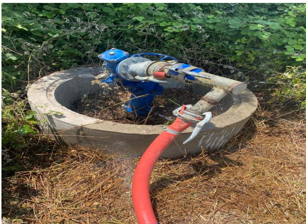
Εικόνα 22 Κτήμα αραβόσιτου 173ΚΒ, διαρροή στο πρώτο τμήμα του αγωγού μεταφοράς νερού προς το κανόνι άρδευσης
