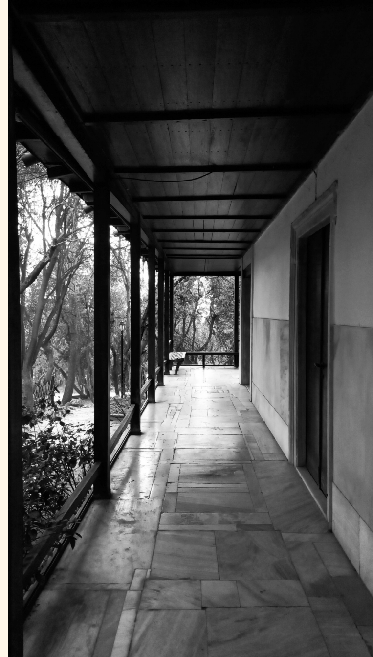
06.25. / Εξωτερικός διάδρομος του Αναπαυτηρίου, 2023. © Έλενα Κουκούλη.
