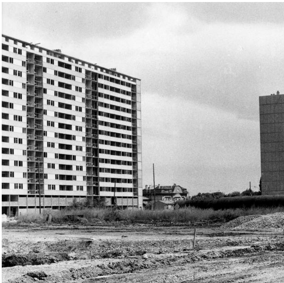
Εικόνα 22. Το Grand Parc υπό κατασκευή, 1963.
