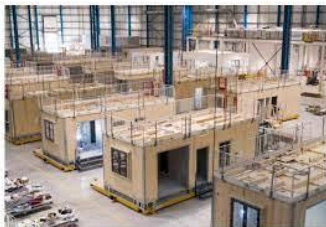
Εικ. 32: Κατασκευή κτιριακών μονάδων με το αρθρωτό σύστημα
