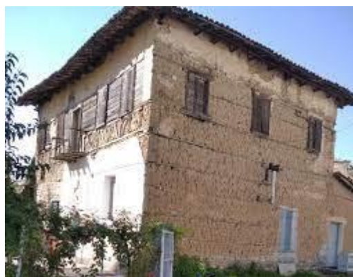
Εικ. 7: Πλινθόκτιστο σπίτι στην Καρδίτσα
