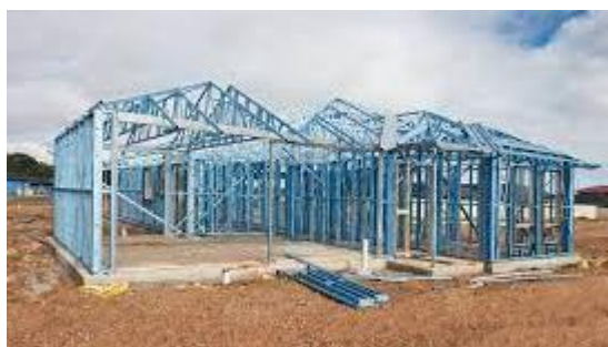
Εικ. 30: Κατασκευή κατοικίας με το σύστημα μεταλλικού σκελετού
