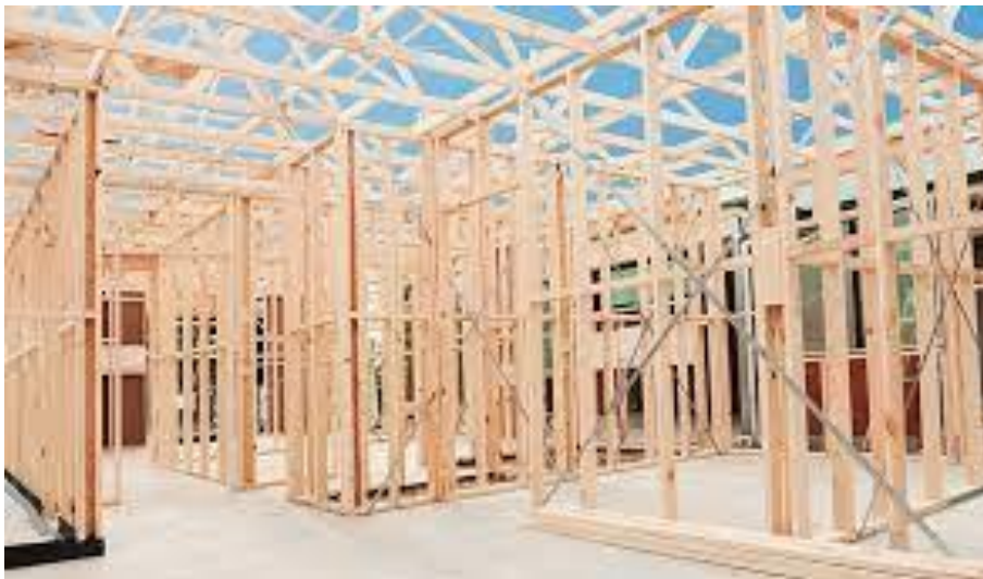
Εικ. 26: Κατασκευή κατοικίας με ξύλινα πλαίσια
