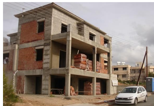
Εικ. 8: Σπίτι στην Κύπρο που κατασκευάζεται με τούβλα
