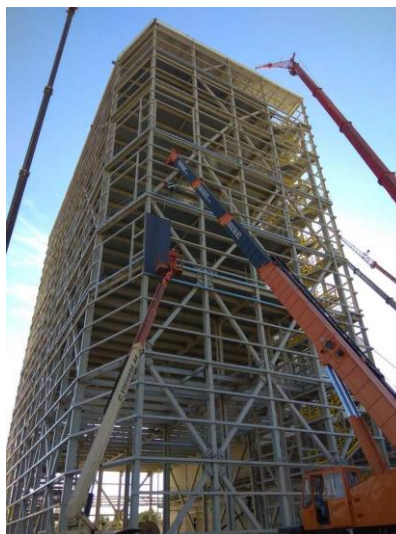
Εικ. 10: Κτίσιμο πύργου με μεταλλικό σκελετό
