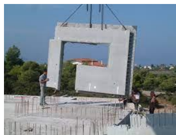
Εικ. 13: Σύστημα δισδιάστατης προκατασκευής.
