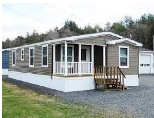
Εικ. 33: Κατοικία προκατασκευασμένη εξ ολοκλήρου στο εργοστάσιο
