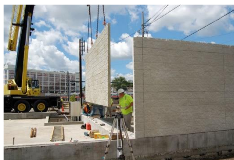
Εικ. 31: Κατασκευή γραφείου με το σύστημα από μπετόν
