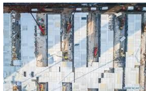
Εικ. 35: Κατασκευή του νοσοκομείου Leishenshan στην Γουχάν
