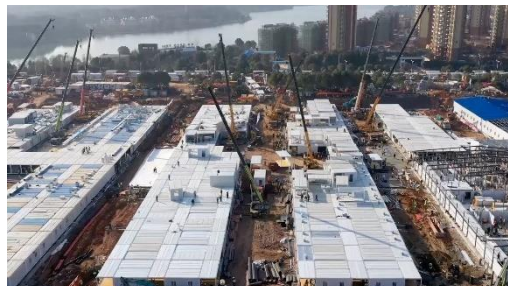
Εικ. 34: Κατασκευή του νοσοκομείου Huoshenshan στην Γουχάν
