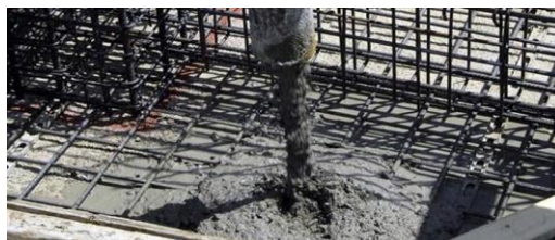
Εικ. 9: Χύσιμο σκυροδέματος σε καλούπι πλάκας
