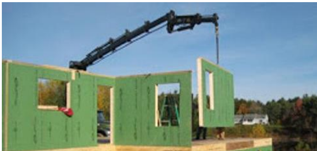
Εικ. 27: Κατασκευή κατοικίας από πλαίσια ξύλου με επένδυση
