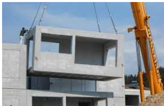
Εικ. 14: Σύστημα τρισδιάστατης προκατασκευής.
