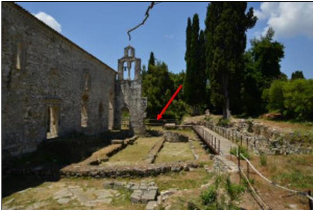
Εικόνα 14. Ημικυκλικό οικοδόμημα που ταυτίστηκε με το ρωμαϊκό ωδείο της πόλης της Κέρκυρας.
