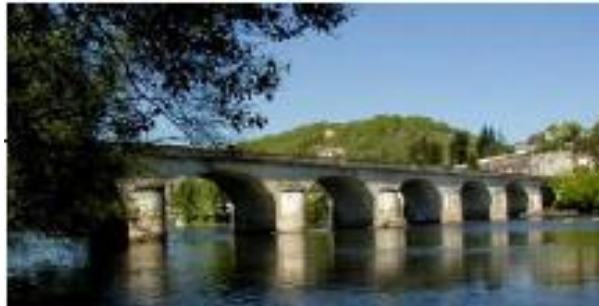
Εικόνα 7.2 Souillac Bridge, Γαλλία 1812, Γέφυρα άοπλου σκυροδέματος, ( en.structurae.de )
