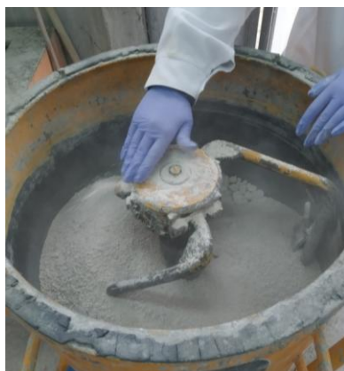
Εικόνα 11.7 Τοποθέτηση αδρανών στην μπετονιέρα
