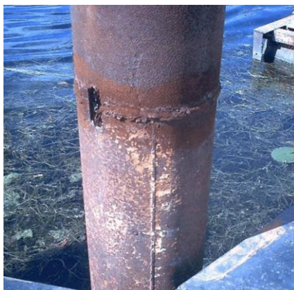
Εικόνα 5.1: Γενική/ομοιόμορφη διάβρωση. 58
