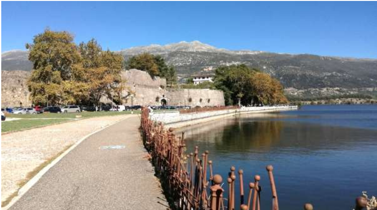
Εικ. 6 Πάρκο Κατσάρη, το μεταλλικό προστατευτικό κιγκλίδωμα,
