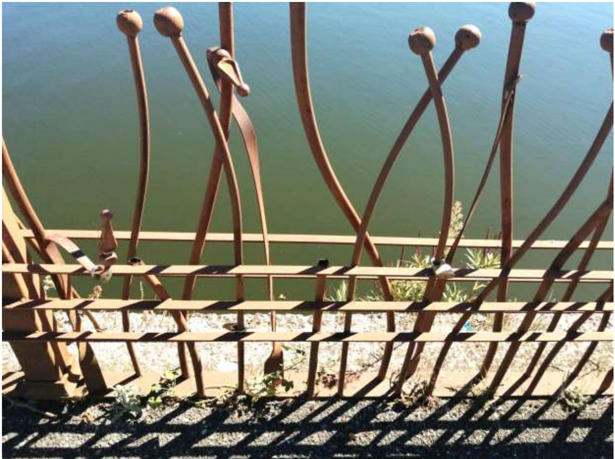
Εικ. 9 το μεταλλικό κιγκλίδωμα. Διακριτές είναι οι φθορές και αλλοιώσεις όπως και τα λουκέτα.
