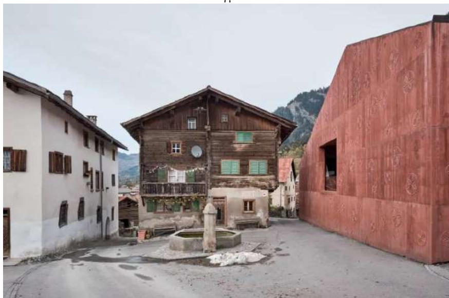
Εικόνα 87 : Σχέση με τα γειτονικά κτίρια
