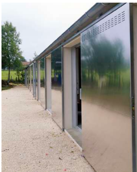
Εικόνα 25 : Μεταλλικά πάνελ, σταθεροί τοίχοι
