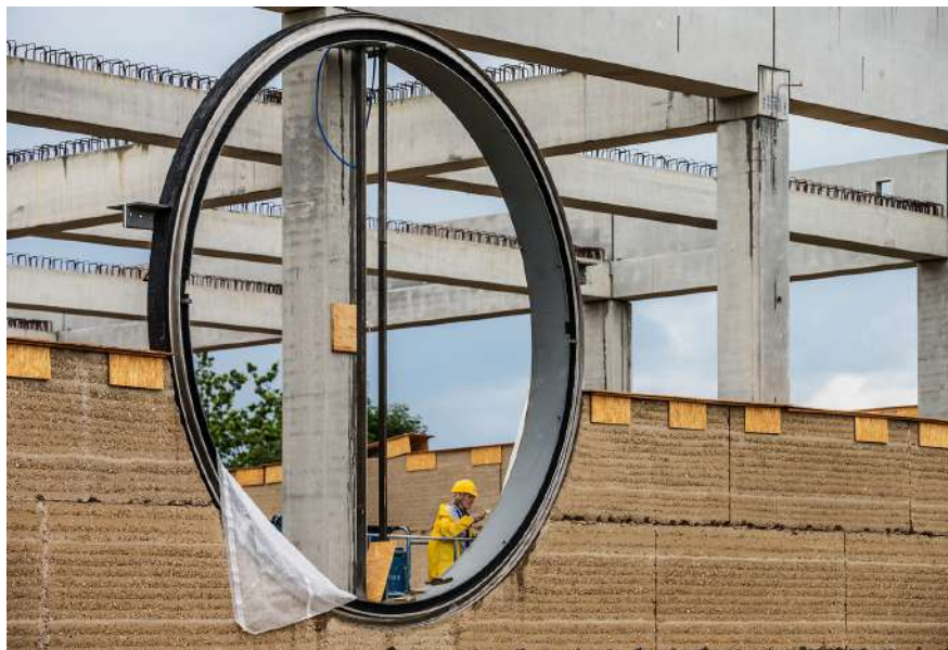
Εικόνα 48 : Κατασκευή στρογγυλού παραθύρου, μοναδική πηγή φωτός
