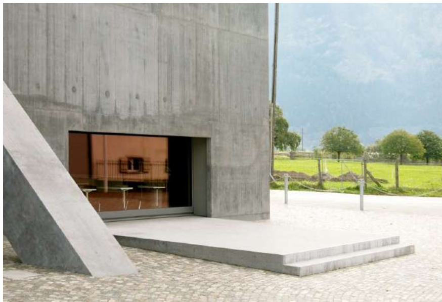
Εικόνα 83 : Βιομηχανικό δάπεδο, αδρό οπλισμένο σκυρόδεμα
