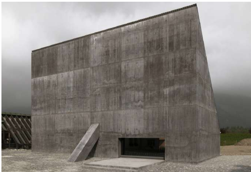
Εικόνα 79 : Συμπαγής κλειστή δομή, αδρό οπλισμένο σκυρόδεμα, αντηρίδα
