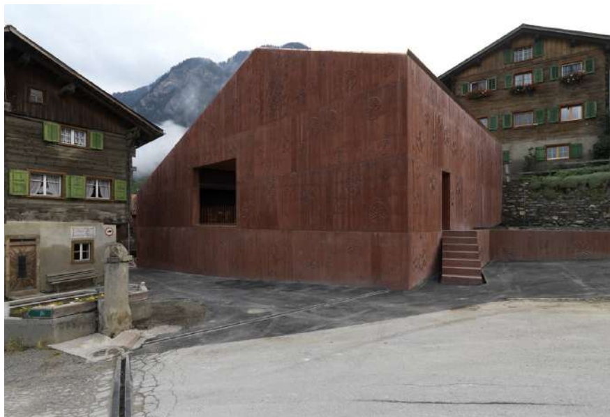
Εικόνα 86 : Κλειστή μονολιθική κατασκευή από οπλισμένο σκυρόδεμα, ανοίγματα
