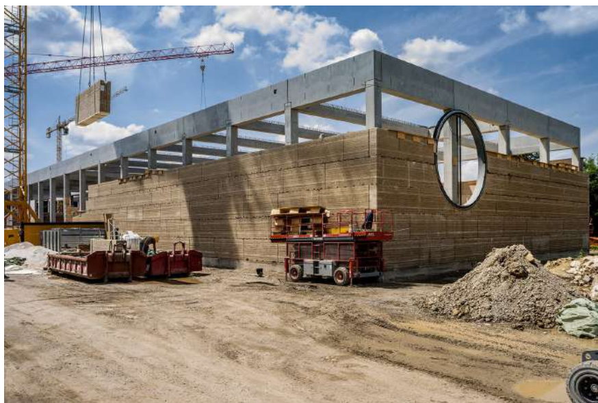
Εικόνα 43 : Προκατασκευασμένος σκελετός από οπλισμένο σκυρόδεμα
