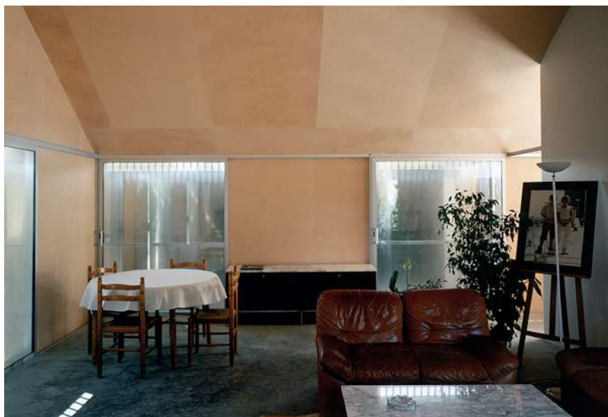
Εικόνα 26 : Επικάλυψη των τοίχων από πάνελ κόντρα-πλακέ θαλάσσης, βιομηχανικό δάπεδο
