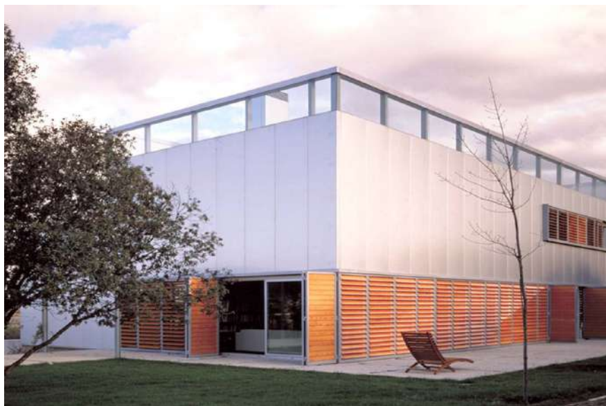
Εικόνα 55 : Θυρίδες εξαερισμού - περσίδες
