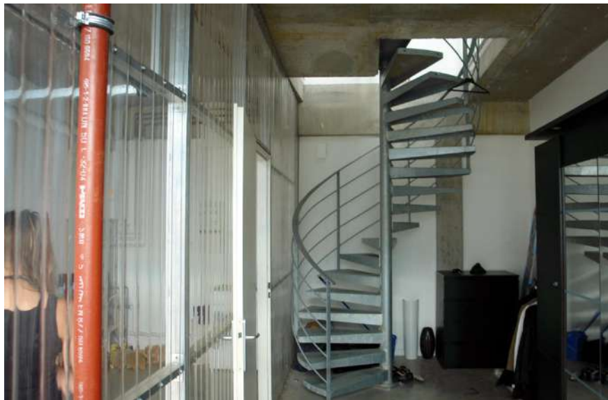
Εικόνα 12 : Μεταλλική σκάλα, τετράγωνη οπή στην πλάκα, ημιδιαφανή χωρίσματα
