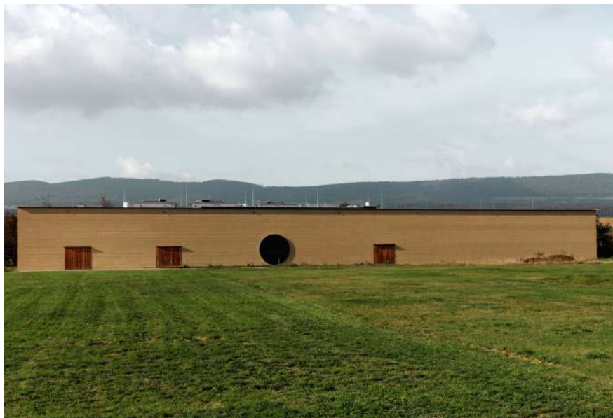
Εικόνα 46 : Γενική εικόνα του κτιρίου
