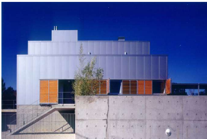
Εικόνα 50 : Πάνελ πολυουρεθάνης, βάση από εκτεθειμένο οπλισμένο σκυρόδεμα, σκάλα, ράμπα
