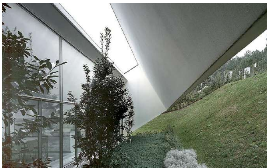
Εικόνα 78 : Απουσία υπαίθριων χώρων, εσωτερική διαμόρφωση αυλής
