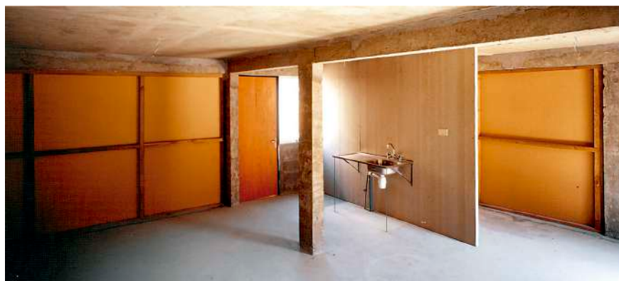
Εικόνα 4 : Εσωτερικό κατοικιών, εκτεθειμένη δομή χωρίς φινιρίσματα
