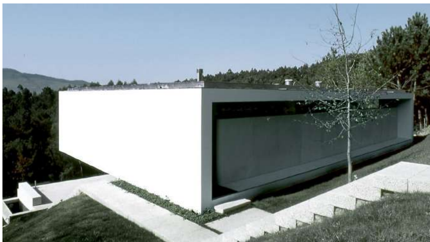
Εικόνα 72 : Κατοικία σε πρόβολο, μονολιθική κατασκευή, κλειστό κουτί.
