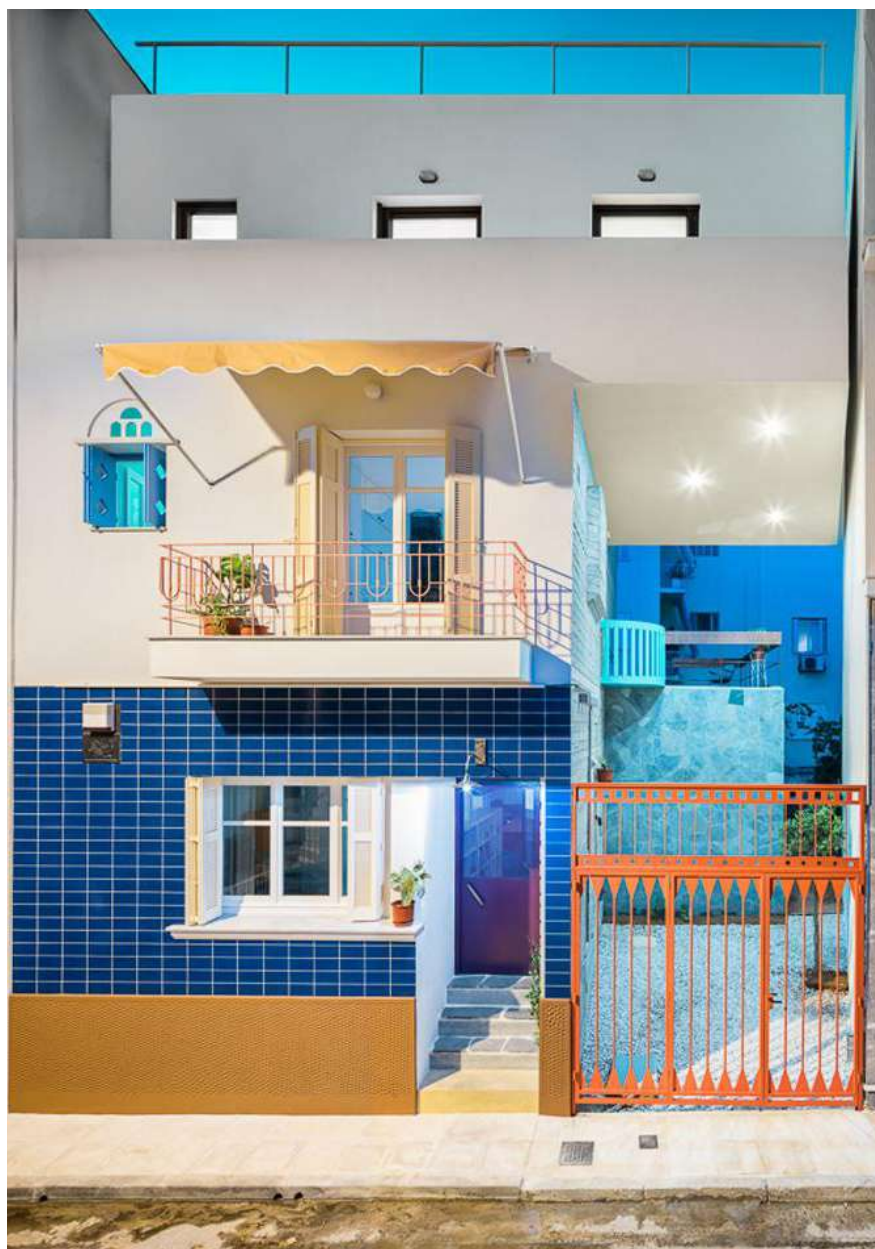
Εικόνα 96 : Όψη προς τον δρόμο/ 3 ζώνες
