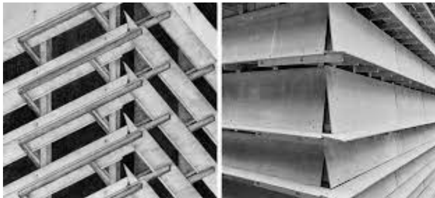
Εικόνα 34 : Ξύλινο πλέγμα, σκελετός κτιρίου
