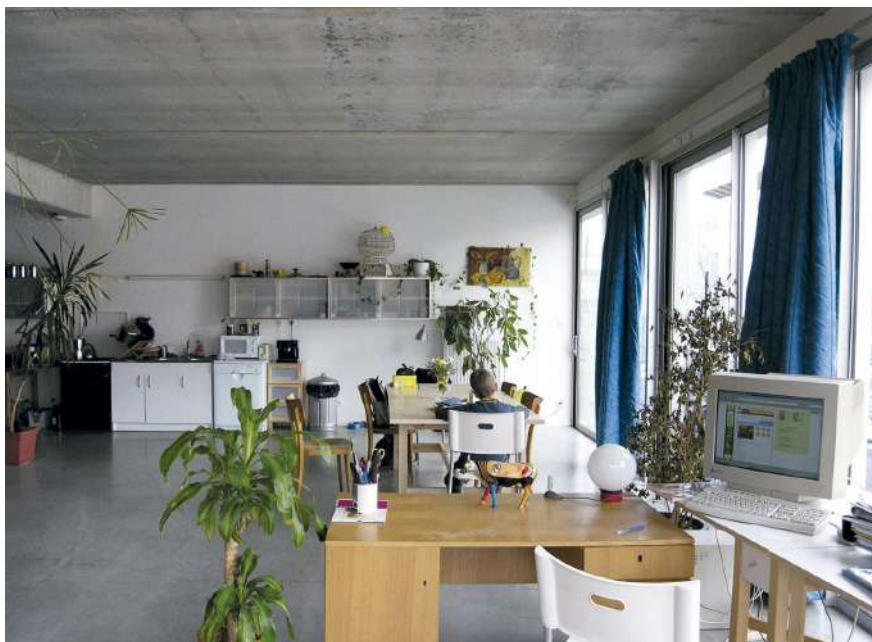
Εικόνα 11 : «Κλειστή δομή», εμφανές σπλισμένο σκυρόδεμα, κανένα φινίρισμα
