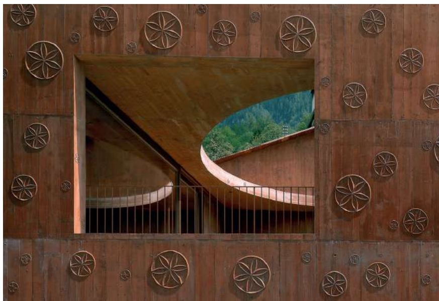
Εικόνα 94 : Ενιαίο υλικό σε όλα τα στοιχεία ακόμα και στις λεπτομέρειες (βλ. κουπαστές)
