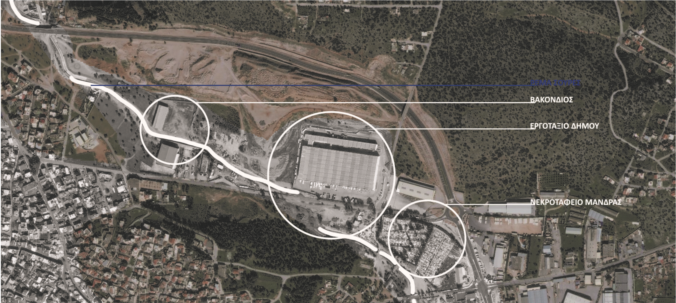
Αυθαίρετα στο ρέμα Σούρες
