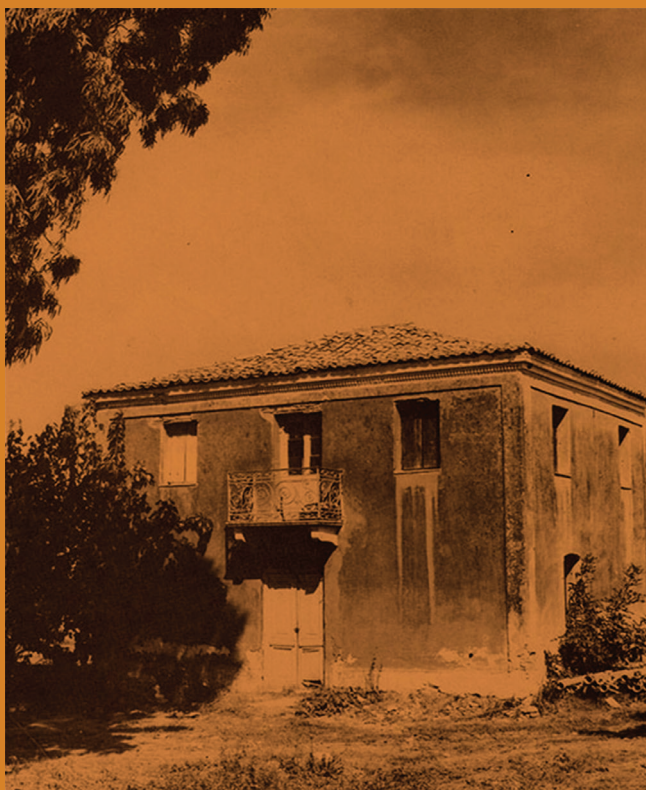
12. Το δώροφο, αρχοντικό μετόχι του κτηματία-σταφιδέμπορου Δ. Ανδρουτσόπουλου στο Καταράχι, στα Λεχαινά Ηλείας (φωτ. Ρωμύλος Παρίσης, 1983).
