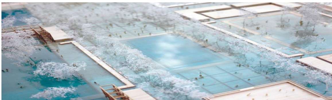
Σχήμα 2.6 Οι πλατείες και τα ανοιχτά χωράφια του Enghaveparken Climate Park στην Κοπεγχάγη της Δανίας είναι αυτήν τη στιγμή ανακαινίζονται για να είναι πλημμυρικοί χώροι κατά τη διάρκεια ακραίων βροχοπτώσεων.(Dc n.d.)
