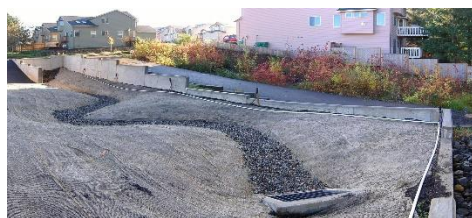
Σχήμα 2.7 Κανάλια που έχουν σχεδιαστεί για να συγκεντρώνουν και να μεταφέρουν την απορροή των όμβριων υδάτων ενώ απομακρύνουν τα συντρίμια και τη ρύπανση(Purvis et al. 2018)
