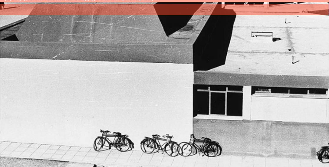
Εικόνα εξωφύλλου-υποκεφαλαίου 4.3: Γυμνάσιο και Λύκειο Λαγκαδά Πηγή: http://domesindex.com/buildings/gymnasio-kai-lykeio-lagkada/
