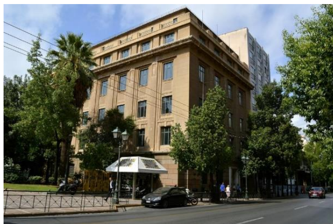
Εικόνα 1.2 «Κτίριο ΤΤΤ», φωτογραφία: Νύσος Βασιλόπουλος
