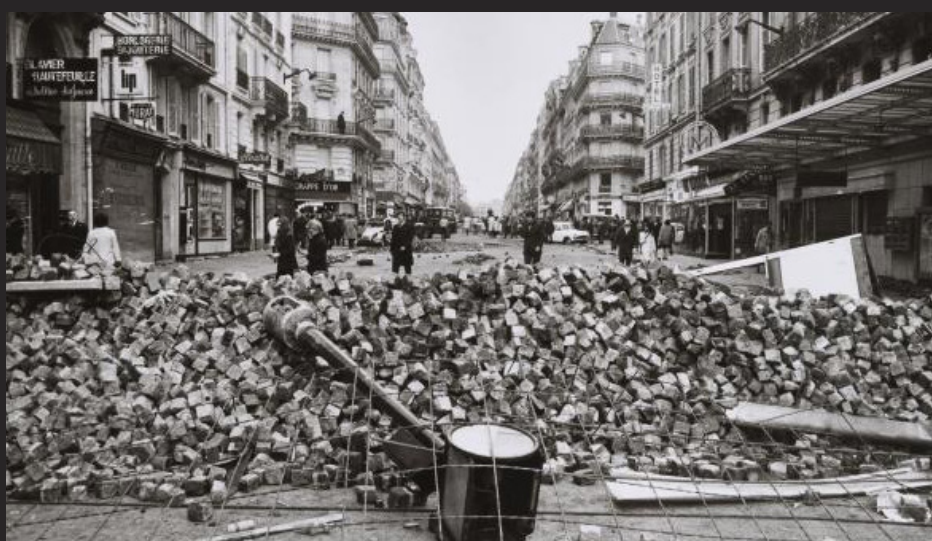
εικ6: Παρίσι, 1968. Οι κυβόλιθοι, εκτός από εκσφενδονιζόμενα όπλα, χρησιμοποιούνται και ως δομικά υλικά για την κατασκευή οδοφραγμάτων.
