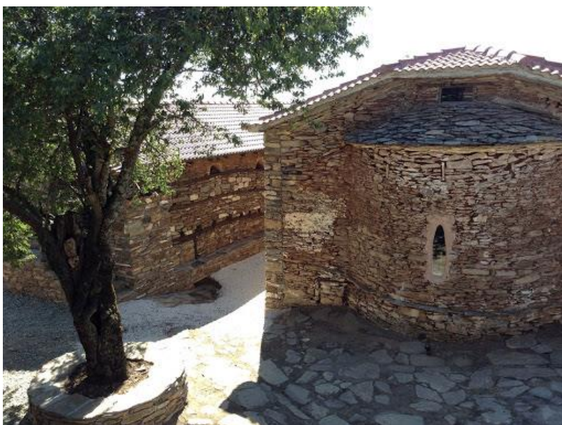
Εικόνα 6: παλαιό καθολικό - ανατολική πλευρά
