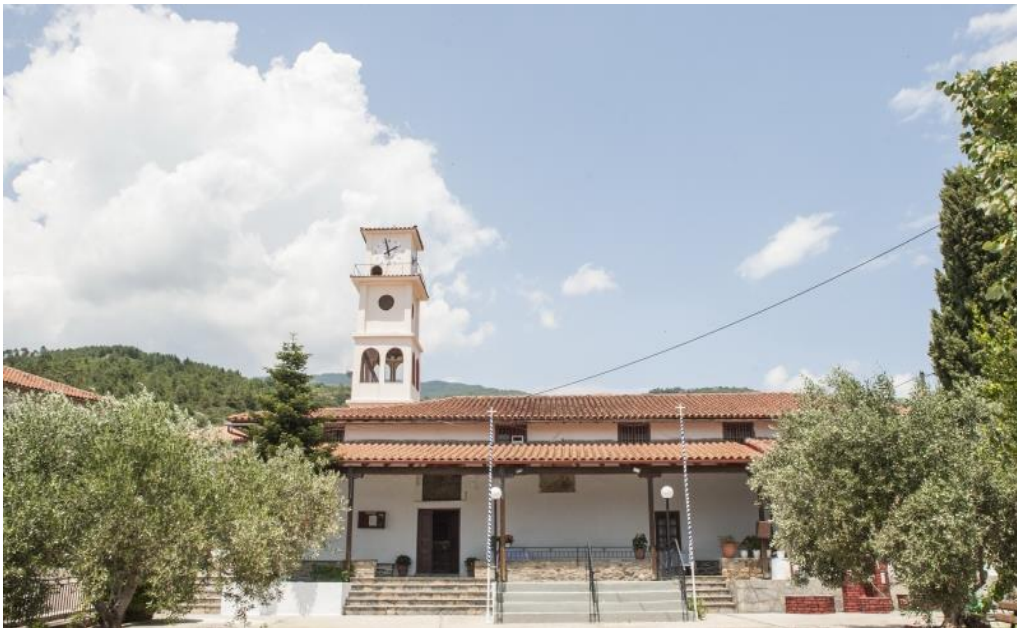
Εικόνα 27: εξωτερική άποψη του ναού
