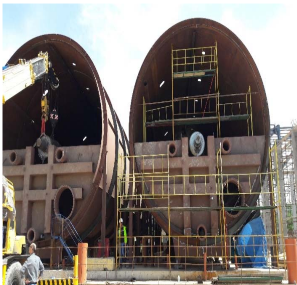
Φωτο 1: Κατασκευή Αναερόβιας χώνευσης για παραγωγή βιοαερίου 2018
