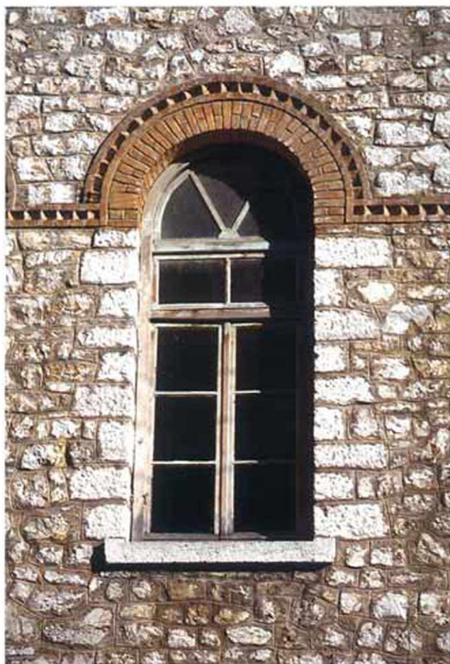
Τα παράθυρα της Καπλανείου με το τοξοτό υπέρθυρο έχουν έντονο εκκλησιαστικό χαρακτήρα και συνδέονται μεταξύ τους με κεραμική διακοσμητική ταινία στο ύψος των γενέσεων των τόξων, η οποία περιτρέπει τους τοίχους του κτιρίου.
