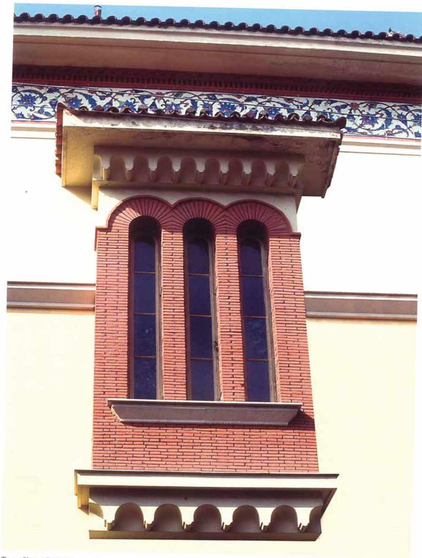
Το προεξέχον τρίλοβο εκκλησιαστικό παράθυρο του Δημαρχείου με το διπλό κυματοειδές γείσομα και τη, βυζαντινού τύπου, κεραμική τοιχοποιία.
