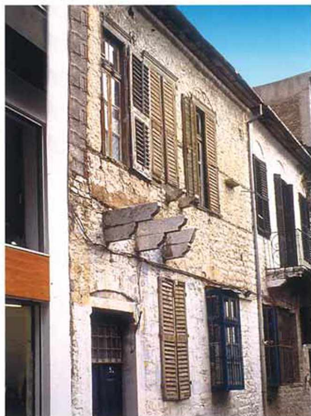
στην οδό Κωλέττη
