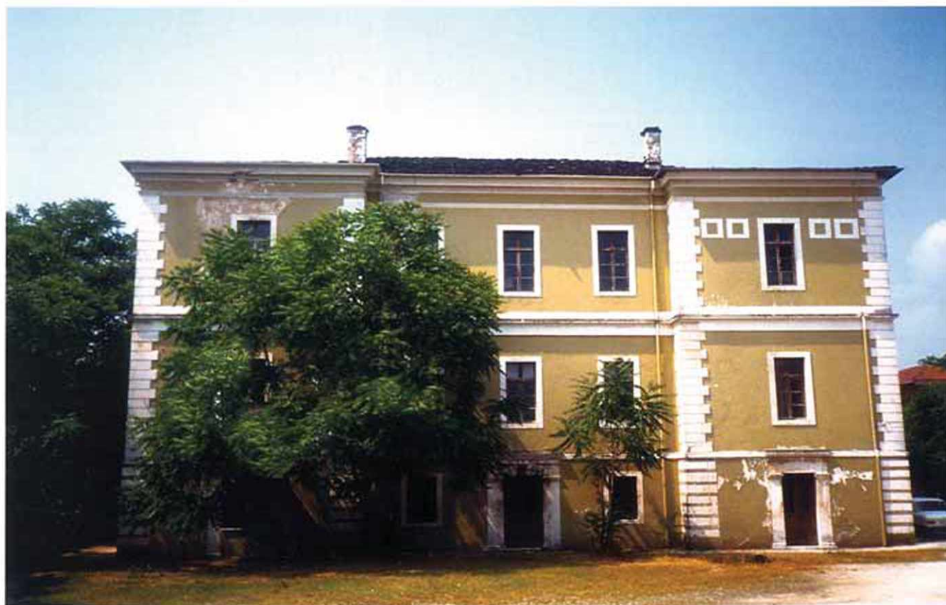
Η ανατολική πλευρά του μεγάρου "Γεωργίου Σταύρου". Η οροφή του κτιρίου είναι σκεπασμένη με τοπική σχιστόπλακα και πέτρινα διακοσμητικά στοιχεία διανδίζουν την όψη του. Ο συνδυασμός πέτρας και επιχρίσματος δίνει επιτυχές αποτέλεσμα.
