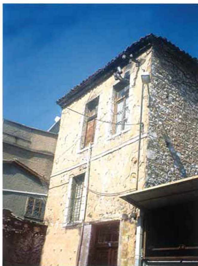
στην οδό Κωλέττη 101
