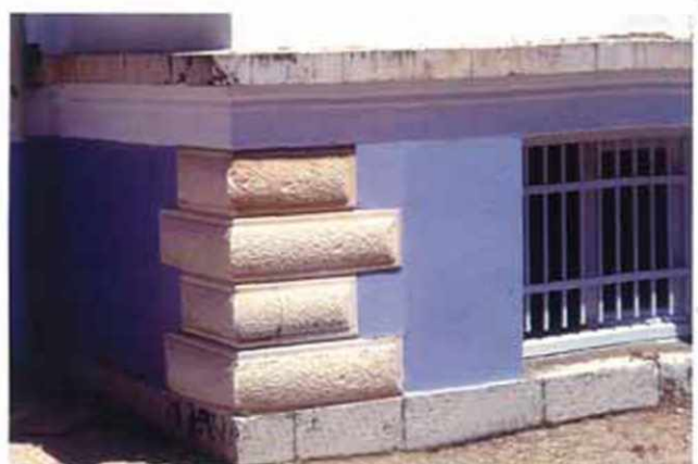
Οι λαξευτοί γωνιόλιθοι και το πέτρινο γείσωμα της βάσης του κτιρίου.
