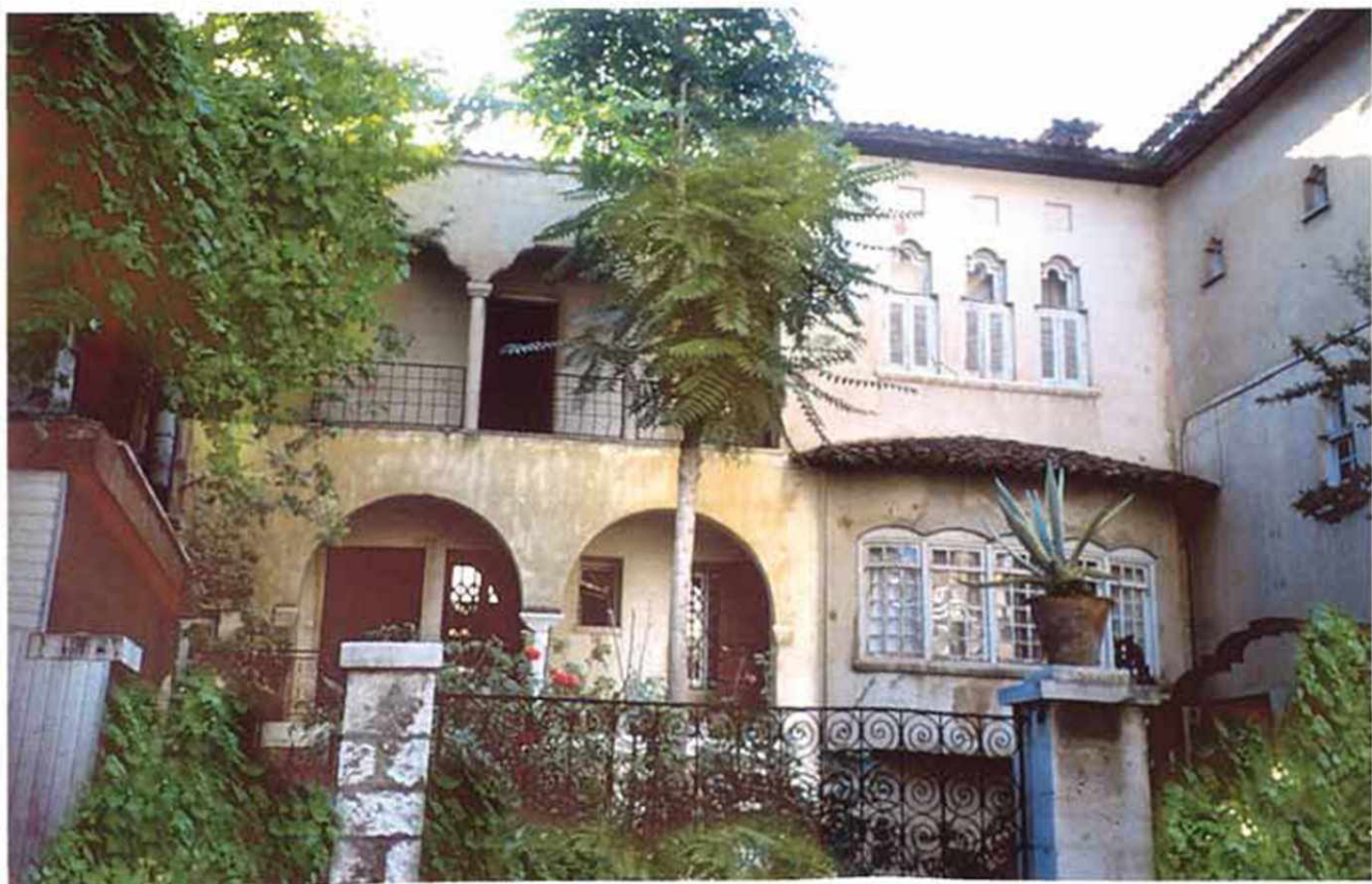
Η όψη του αρχοντικού του Κώστα Φρόντζου που κατασκευάστηκε με τις υποδείξεις του ίδιου του μεγάλου οραματιστή.
