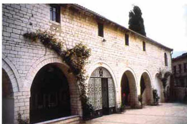
Η νότια πλευρά του ναού με την πέτρινη τοξοτή κιονοστοιχία.
