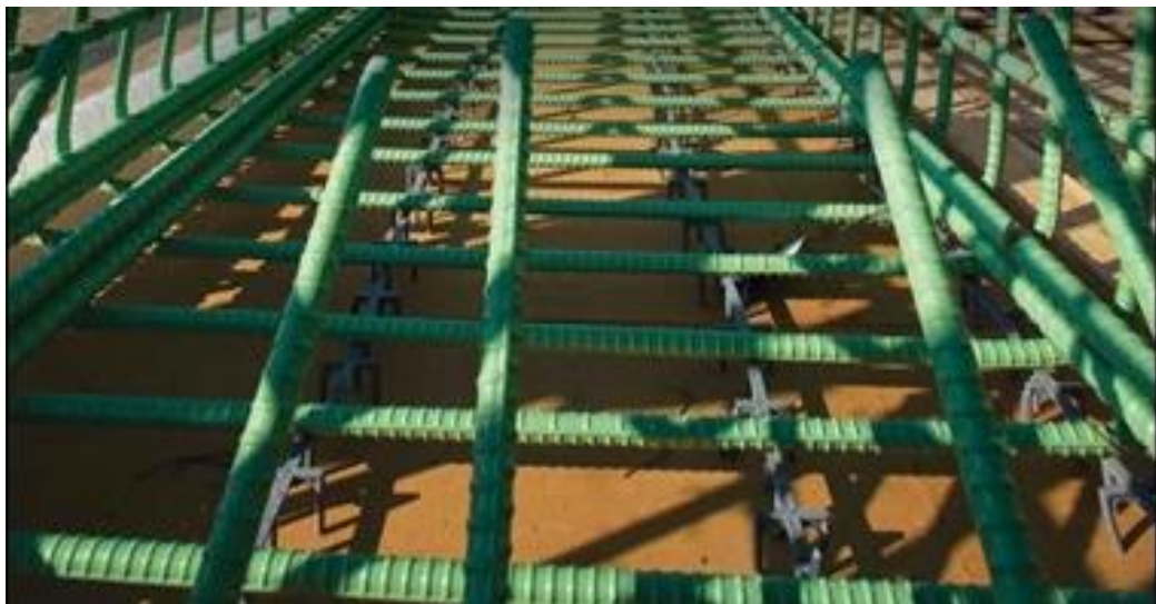
Σχήμα 2.14 Τοποθέτηση επικαλυμμένων ράβδων σε έργα γεφυροποιίας [12]
