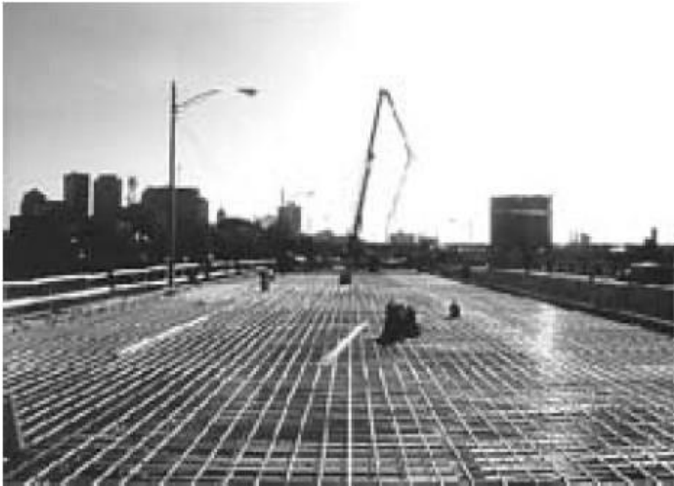
Σχήμα 2.15 Εφαρμογή ράβδων GFRP [12]
