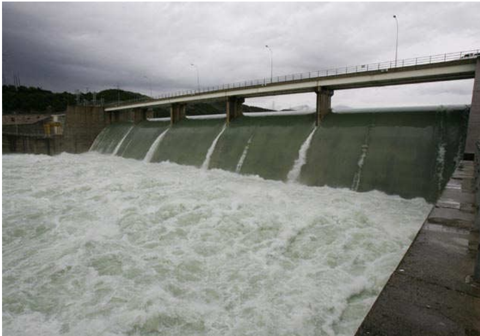
Εικόνα 3-23 Πλημμύρα 2005, Φράγμα Πουρναρίου II
