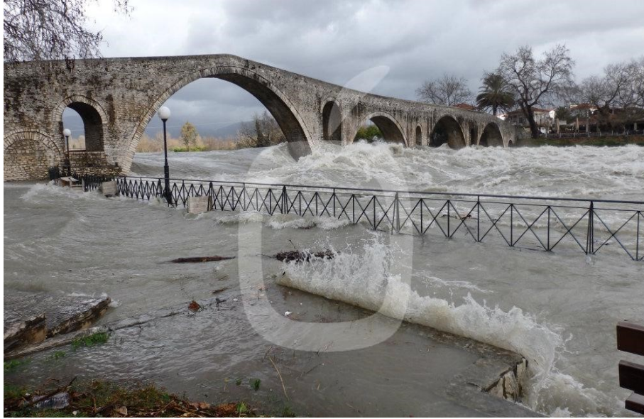
Εικόνα 3-26 Πλημμύρα 2015, Παλαιά Γέφυρα Άρτας
