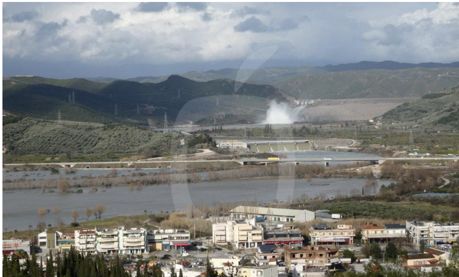
Εικόνα 3-25 Πλημμύρα 2015, Φράγμα Πουρναρίου
