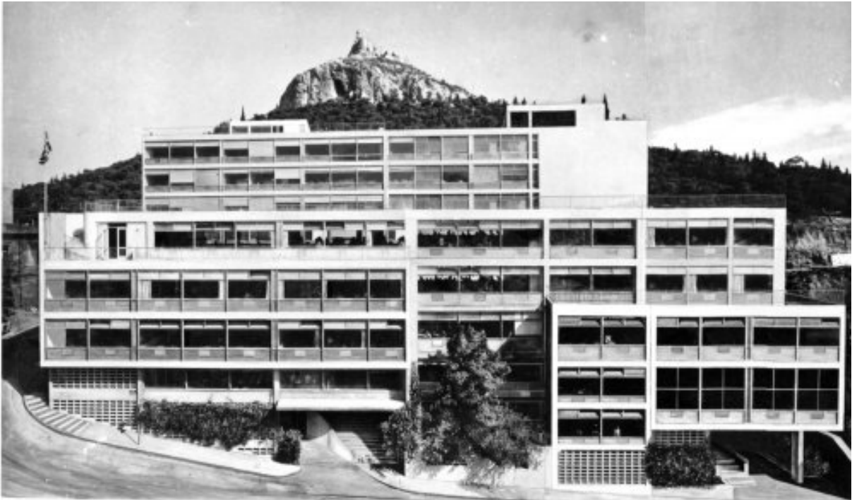
εικόνα 1: συνολική άποψη του κτιριακού συγκροτήματος γραφείων Δοξιάδη, ως είχε στην αρχική του φάση.
