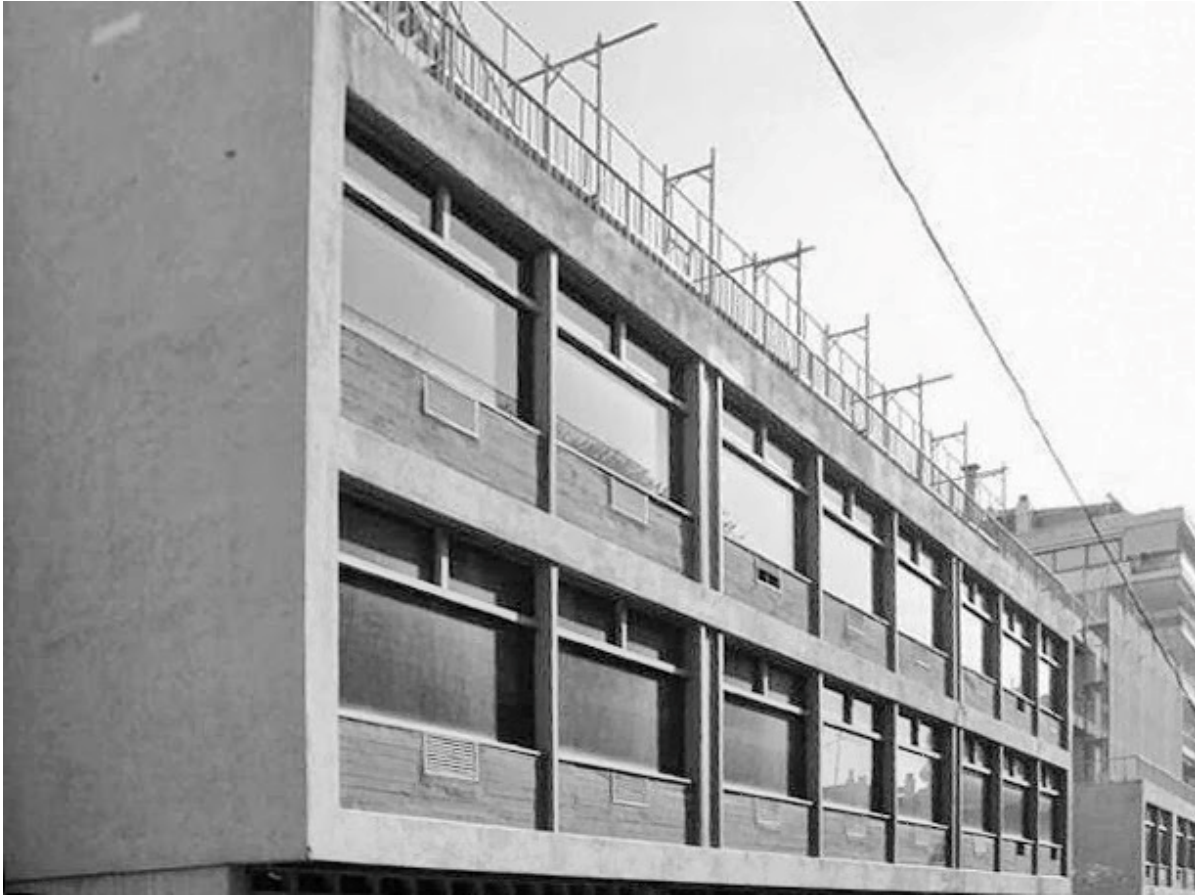
εικόνα 4: η διάταξη των κουφωμάτων ως είχε αρχικά, στα επαναλαμβανόμενα πλαίσια του κανάβου των όψεων.
