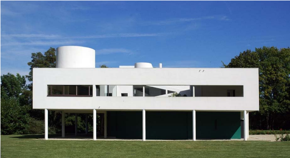
εικόνα 5: κατάσταση διατήρησης της villa Savoye μετά την τελευταία αποκατάσταση του 2010.
