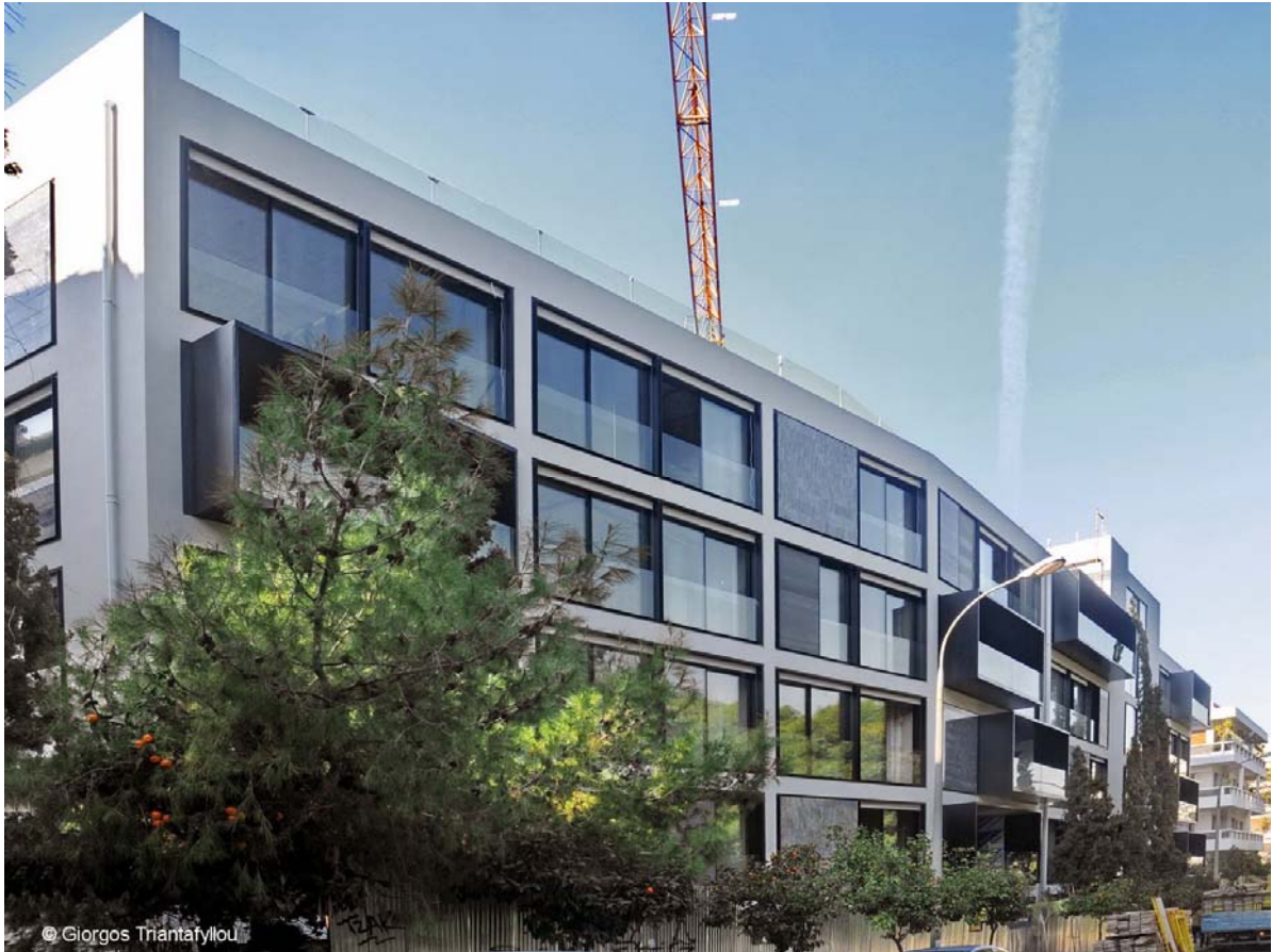
εικόνα 13: άποψη της ανατολικής όψης του κτιρίου One Athens (αρχικά κτίριο Γραφείων Δοξιάδη) μετά τις εργασίες μετασκευής και διατηρώντας την αρχική δομοστατική διάρθρωση.
