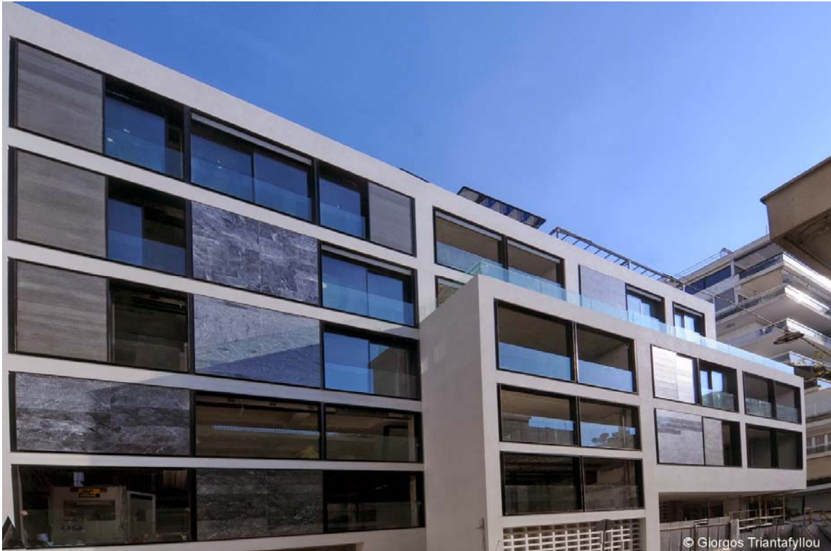
εικόνα 12: άποψη της δυτικής όψης του κτιρίου One Athens (αρχικά κτίριο Σχολής Δοξιάδη) μετά τις εργασίες μετασκευής και διατηρώντας την αρχική δομοστατική διάρθρωση.
