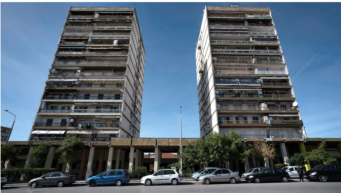
38. Θεσσαλονίκη, "Οι δωδεκάωρφες", οδός Λαγκαδά, Ξηροκρήνη
