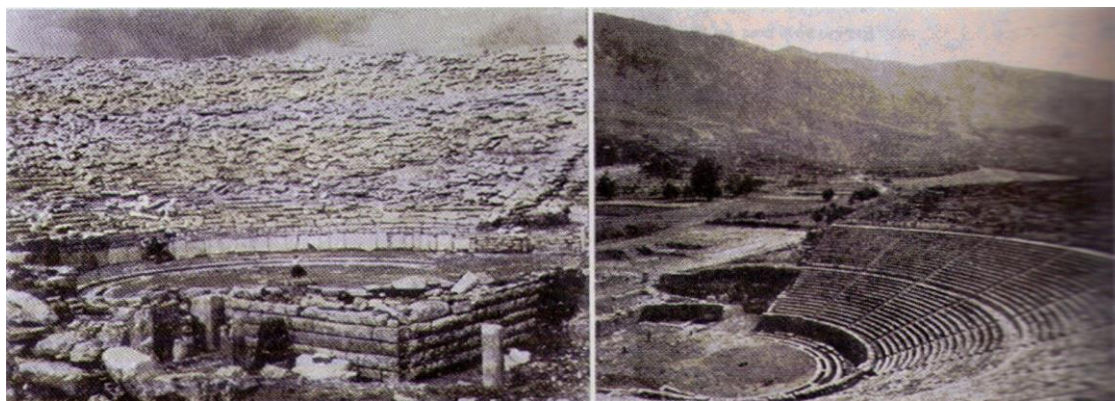
Εικ. 22: Το αρχαίο θέατρο πριν και μετά την αναστήλωση.
