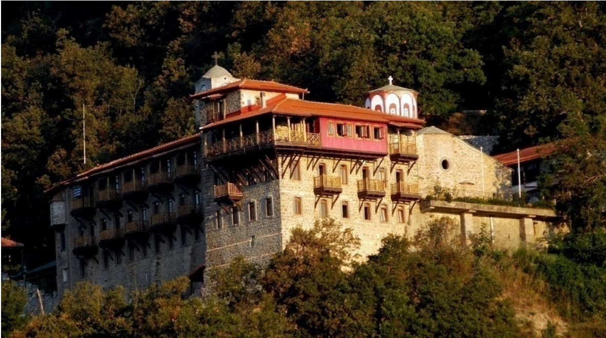
Εξωτερική όψη της μονής Κορώνας. Αγραφα (εικ. 91)
