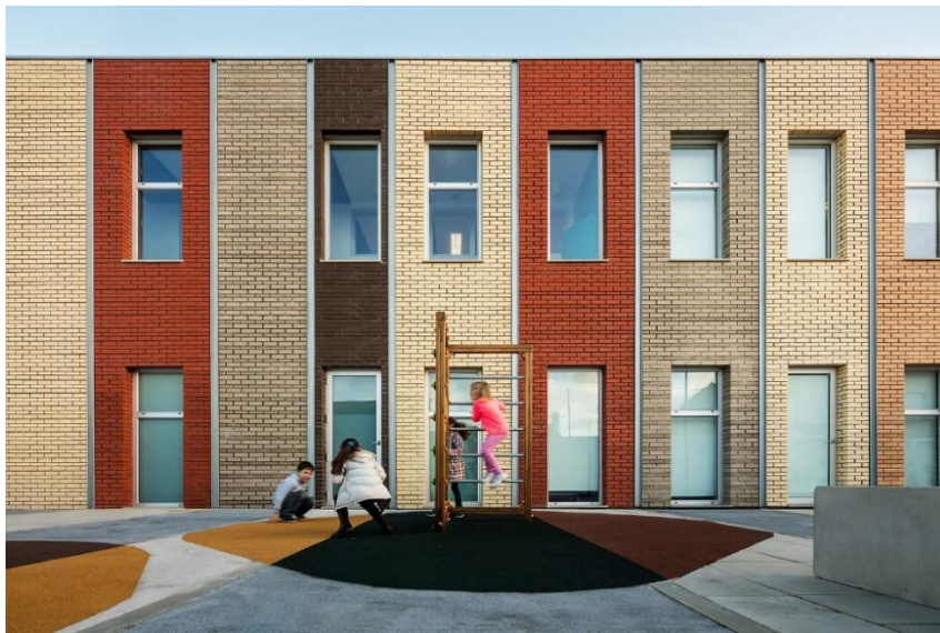
Εικόνα 23: Ανακαίνιση σχολείου Murteira / NOZ Arquitectura. Όψη κτιρίου από τούβλα και κεραμικά.
