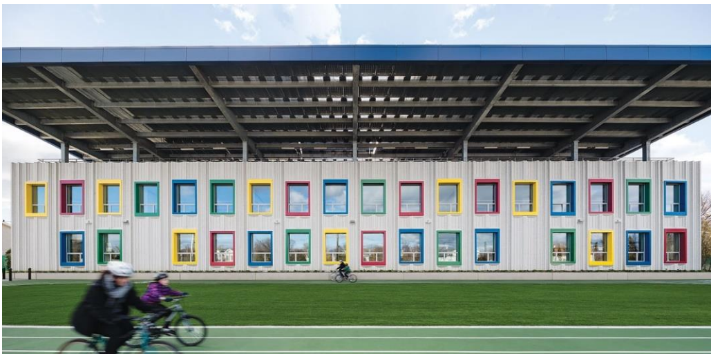
Εικόνα 24: Σχολείο μηδενικής κατανάλωσης ενέργειας στη Νέα Υόρκη. Όψη με προκατασκευασμένα πετάσματα σκυροδέματος.
