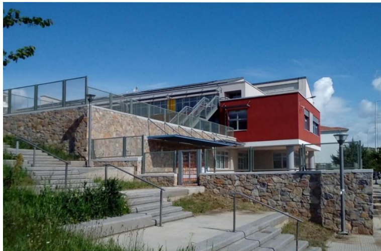
Εικόνα 29: Η κτιριακή μονάδα του βιοκλιματικού σχολικού συγκροτήματος δημοτικού – νηπιαγωγείου στην Κοζάνη.
