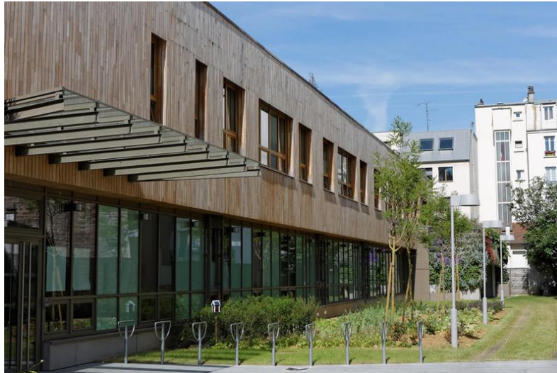
Εικόνα 46: Η μπροστινή όψη της σχολικής μονάδας του Eco Nursery and Primary School.
