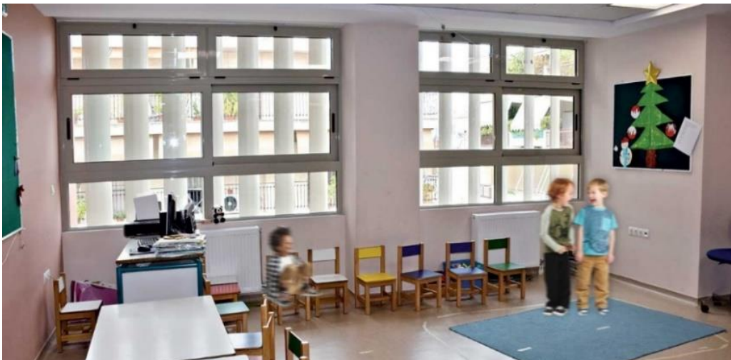
Εικόνα 4: Νηπιαγωγείο με βιοκλιματικά στοιχεία στην Αθήνα. Αίθουσα διδασκαλίας που προστατεύει τα παιδιά από τις υπεριώδεις ακτίνες με την χρήση κάθετων σκίαστρων.
