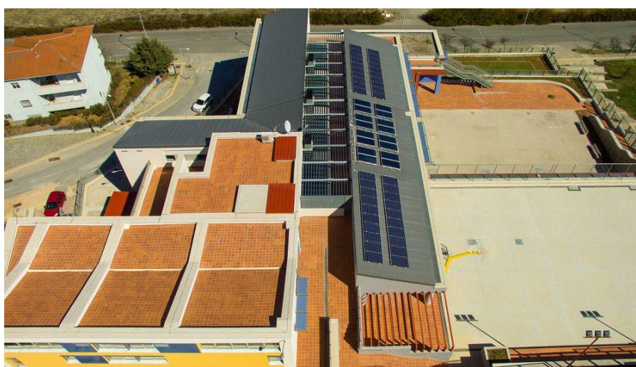
Εικόνα 34: Άνοψη του κελύφους του βιοκλιματικού σχολικού συγκροτήματος δημοτικού – νηπιαγωγείου στην Κοζάνη.
