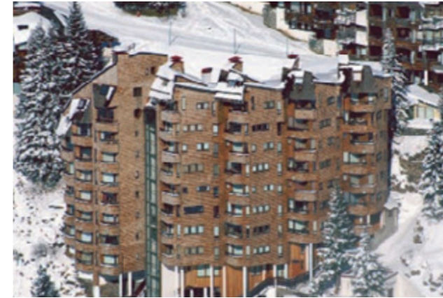
Εικόνα 76 : Les Hauts Forts – Γυάλινος ανελκυστήρας – Κατακόρυφη κίνηση
