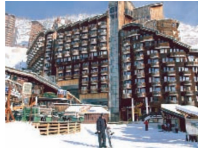
Εικόνα 78 : κτίριο Snow στο χωριό Crozats - Γυάλινος ανελκυστήρας – κατακόρυφη κίνηση
