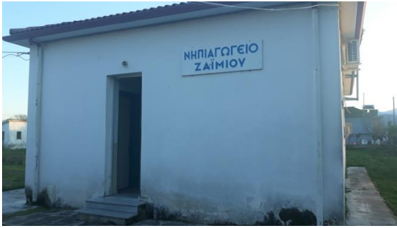
Εικόνα 338: Εξωτερική όψη κτιρίου
