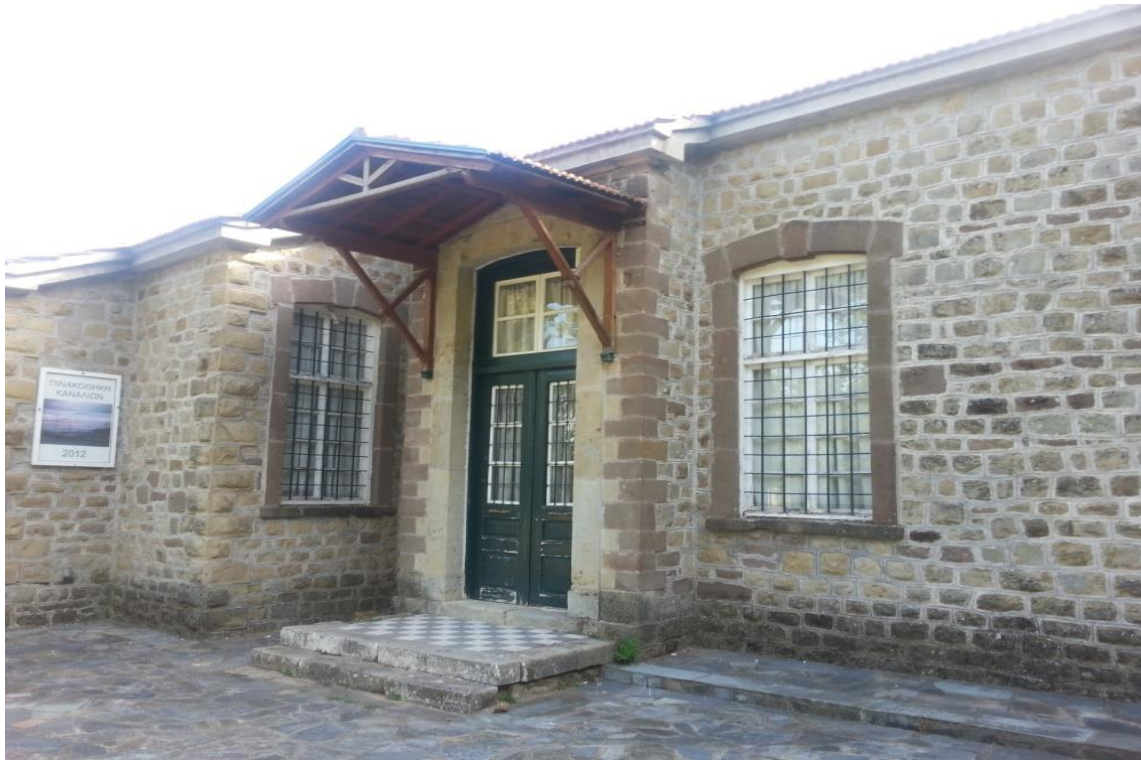
Εικόνα 102: Εξωτερική όψη κτιρίου
