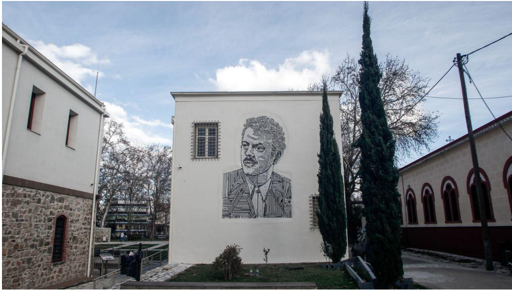
Εικ. 19. Δυτική όψη του Διοικητηρίου 409
