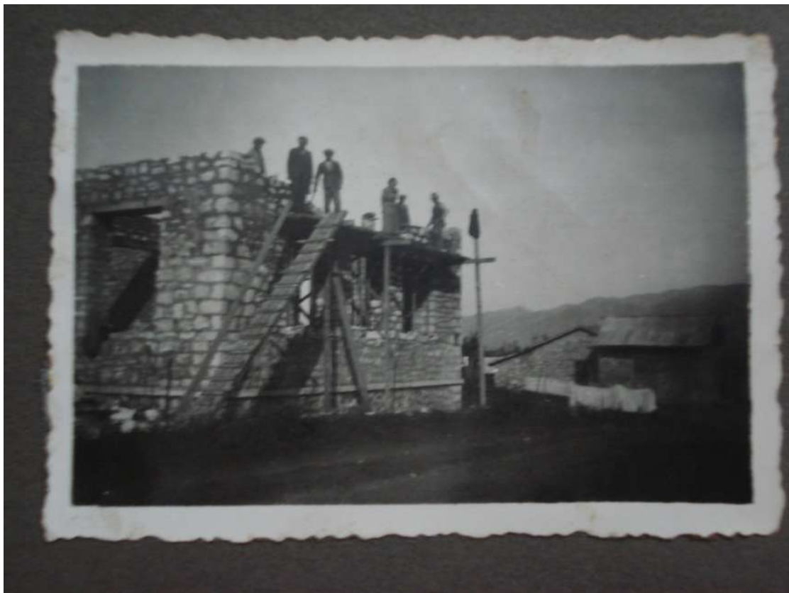
7. Προσωπική εργασία των κατοίκων για την ανέγερση του σχολείου.
