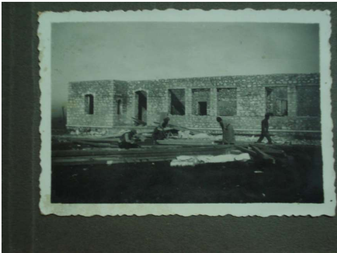
6. Φωτογραφίες από την ανέγερση του σχολείου Ανατολής.
