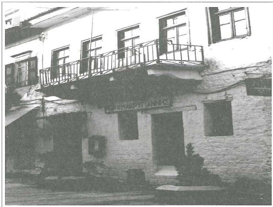
Οικία μετά καταστήματος, κειμένη επί τής οδου Πριοβόλου (1850).
