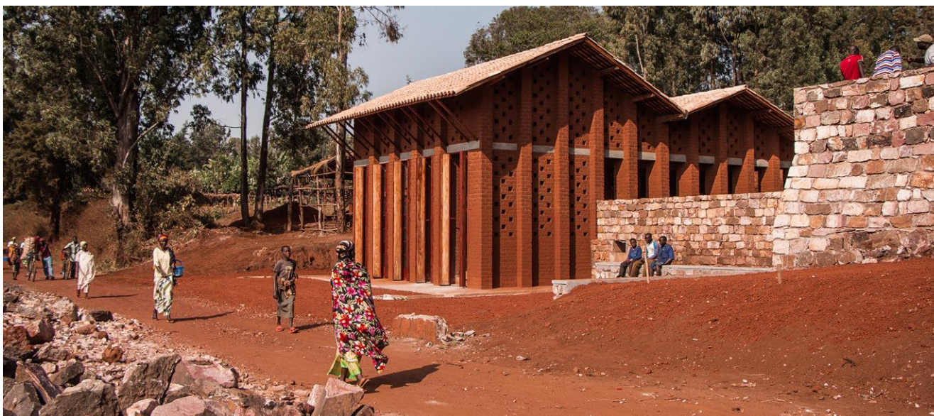
Εικ.203: Διακρίνονται τα διάτρητα σημεία καθώς και οι μικρές αποστάσεις μεταξύ των υποστυλωμάτων
