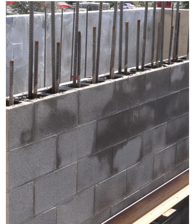
Εικ.123: Τοποθέτηση σιδερένιου οπλισμού για ενίσχυση της φέρουσας κατασκευής
