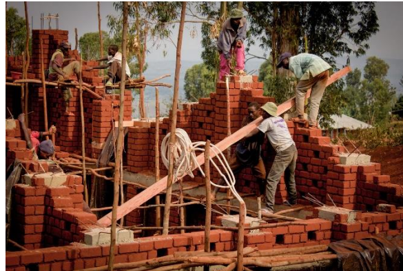
Εικ.204: Κατασκευή τοιχοποιίας με CEB
