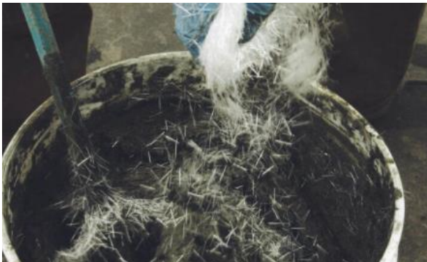
Εικ.111 : Προσθήκη στο μίγμα σκυροδέματος ίνες υάλου
