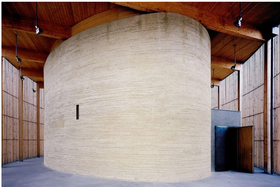
Εικ. 175: Ο εσωτερικός διάδρομος που δημιουργείται από τις ξύλινες περσίδες και της τοιχοποιίας.
