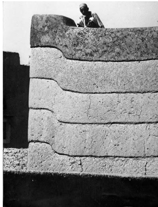
Εικ.86: Τοιχοποιία με την τεχνική cob, στην Υεμένη (Najran mud-house)
