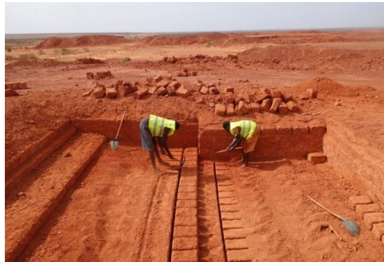
Εικ.94: Διαμόρφωση cut blocks
