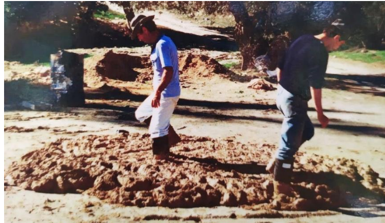
Εικ. 51: Το μίγμα πατιέται κάθε πρωί και βράδυ, καθώς αναμιγνύεται σε αυτό νερό κατά την διάρκεια μιας ή αρκετών μερών, ανάλογα την χρήση του
