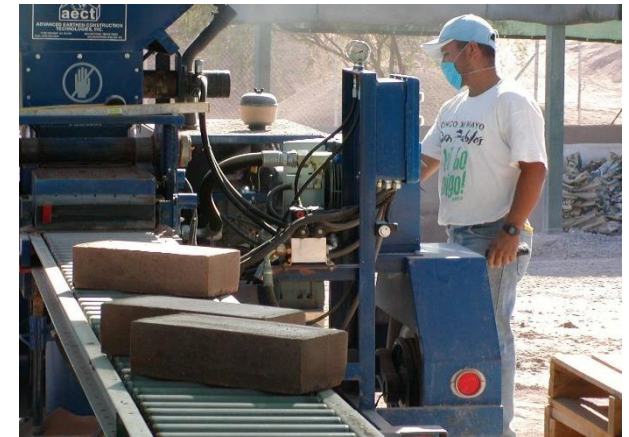
Εικ. 168: Κατασκευή συμπιεσμένων μπλοκ στο εργοτάξιο
