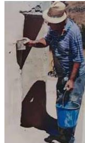
Εικ. 54: Το λευκό επίχρισμα ρίχνεται με ένα τενεκεδάκι ή τοποθετείται με βούρτσα
