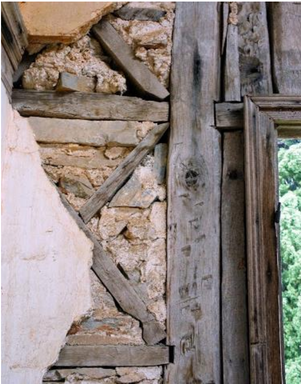
Εικ.106: Τοιχοποιία με την τεχνική cob σε σκελετό, διακρίνεται ο ξυλινος σκελετος ο οποίος σε μερικές περιπτώσεις μπορεί να προστεθούν χαλίκια και στην συνέχεια πληρώνεται με χώμα
