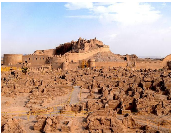
Εικ.39: Μετά την ανοικοδόμηση (Σεπτέμβριος του 2016)
