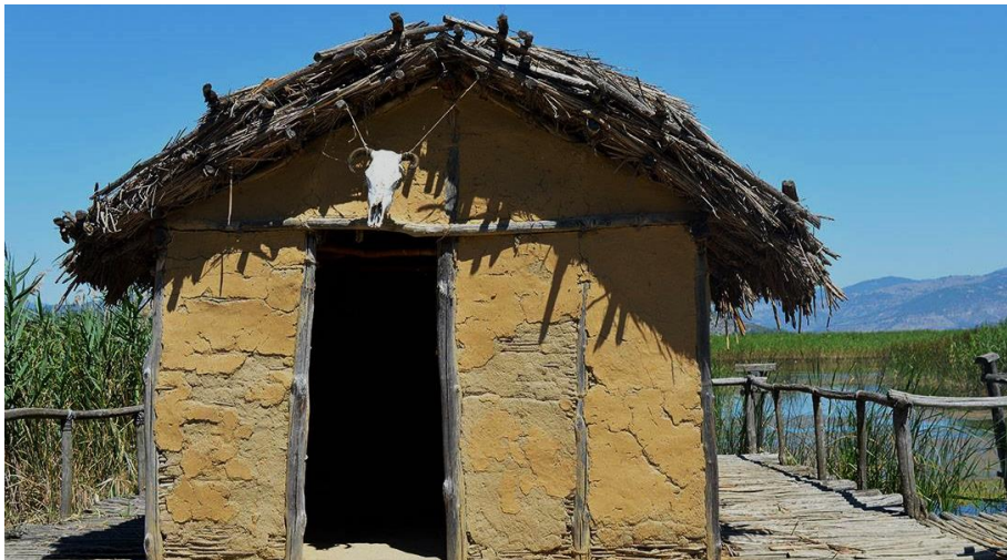
Εικ. 60: Το χώμα ως στοιχείο πλήρωσης, σε ξύλινο σκελετό και δίρριχτη στέγη καλυμμένη από άχυρο.
