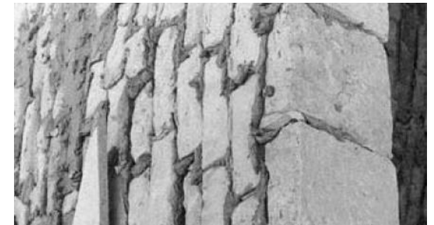
Εικ.132 : Λεπτομέρεια σύγχρονης συναρμογής τούβλων με κονίαμα στην Αίγυπτο για κατασκευή θόλων.
