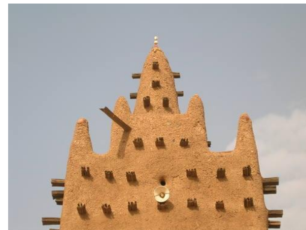
Εικ. 27: Φαίνονται οι σειρές από τις αντηρίδες στην όψη του κτιρίου
