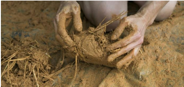
Εικ.110 : Προσθήκη άχυρου για ενίσχυση του υλικού
