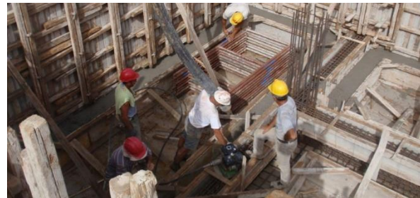
Εικ. 152: Σε ξυλότυπο τοποθετείτε σιδερένιος οπλισμός και στην συνέχεια το σκυρόδεμα
