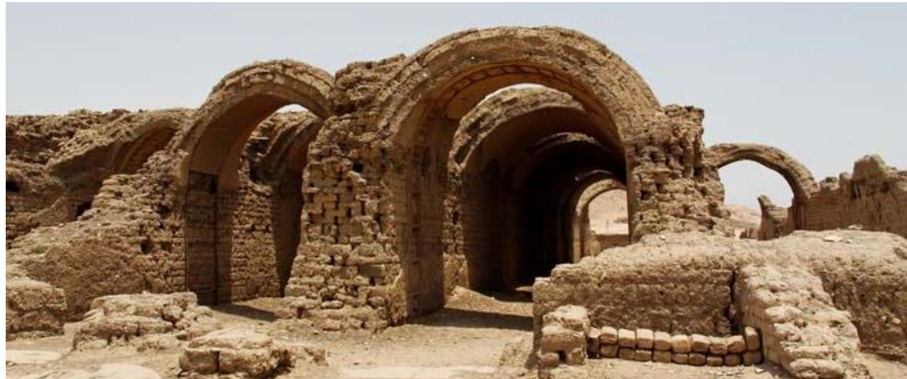
Εικ. 11: Αποθήκες του Ραμσείου στεγασμένες με κυλινδρικούς θόλους
