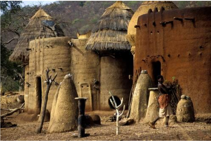
Εικ.30: Φαίνονται οι επίπεδες και οι κωνικές στέγες των <<Takieta>> καθώς και οι αντηρίδες που προεξέχουν.
