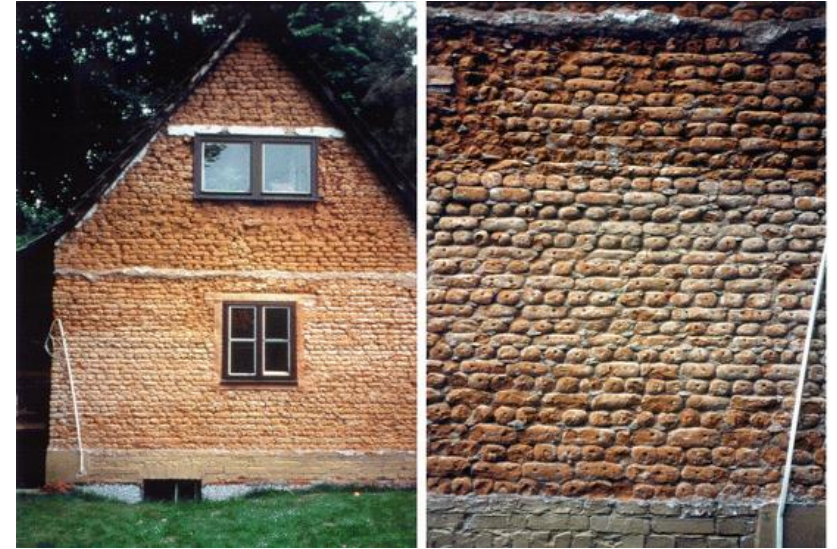
Εικ.90: Κτίριο με ανεπίχριστη τοιχοποιία, στην Γερμανία
