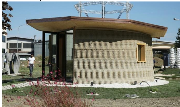
Εικ.122: Κατοικία με 3D εκτυπωτή
