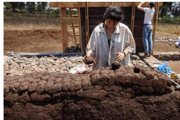
Εικ.112:Τοποθέτηση δομικών μονάδων διαδοχικά για την κατασκευή φέρουσας τοιχοποιίας
