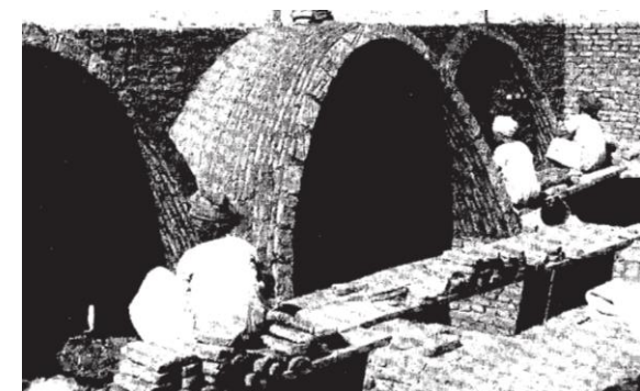
Εικ. 13: Κατασκευή κυλινδρικών όψεων από εκπαιδευμένους νέους τεχνίτες
