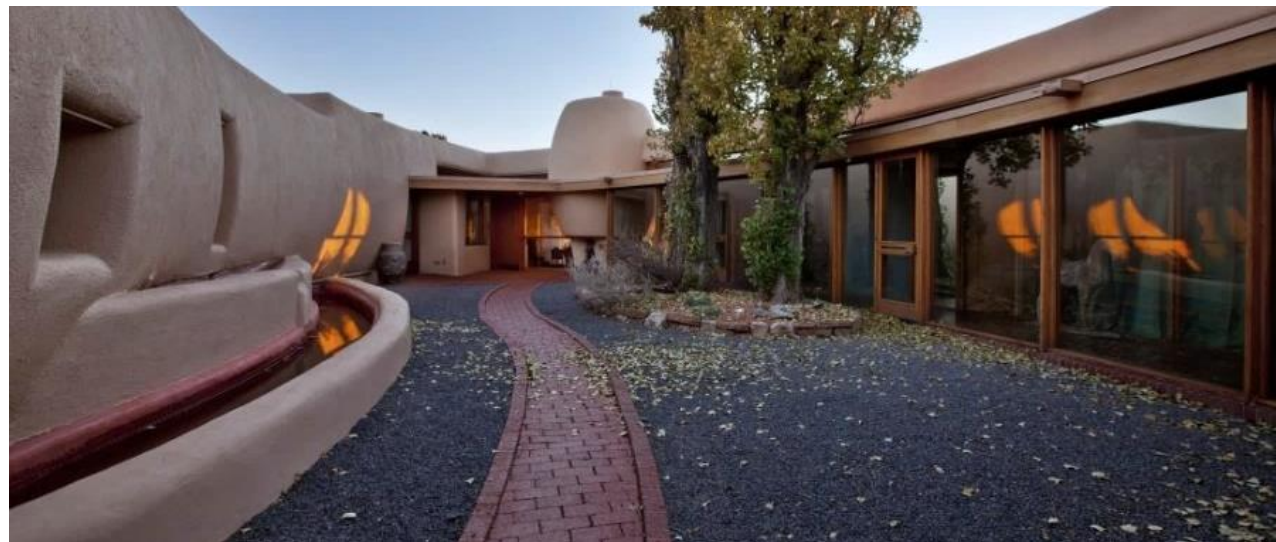
Εικ. 181: Η εσωτερική αυλή της κατοικίας. Αριστερά φαίνεται η γήινη τοιχοποιία ενώ δεξιά φαίνεται ότι προστέθηκε ένας ξύλινος διάδρομος
