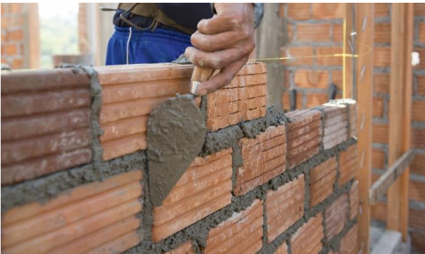
Εικ.147: Χρήση τσιμεντοκονίας ως συνδετικό υλικό των δομικών μονάδων
