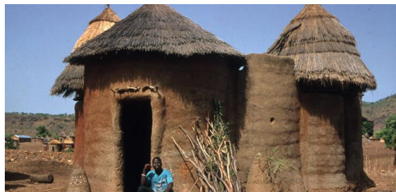
Εικ.4: Τεχνική κατασκευής cob
