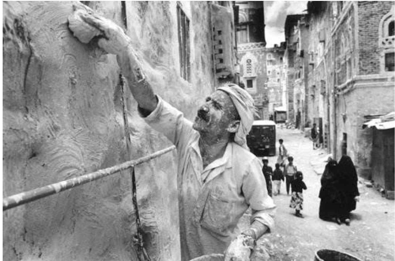
Εικ.69: Στην Υεμένη, σοβάτιζαν τα γήινα κτίρια τους καίγοντας ασβεστόλιθο
