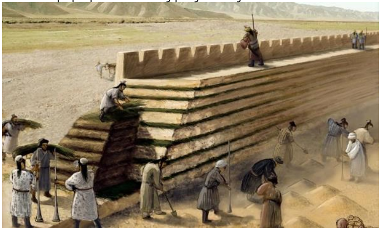
Εικ. 37: Απεικόνιση για τον τρόπο κατασκευής του σινικού τείχους με την τεχνική συμπιεσμένης γης
