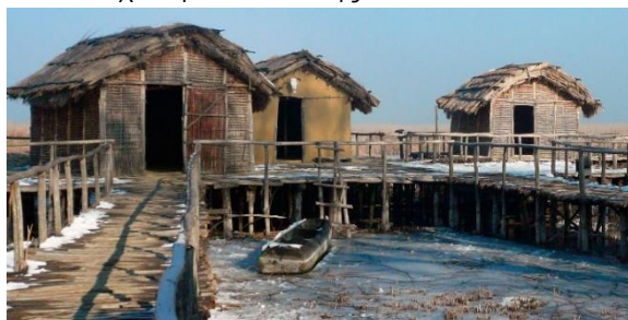
Εικ.5:Το χώμα ως υλικό πλήρωσης σε ξύλινο σκελετό
