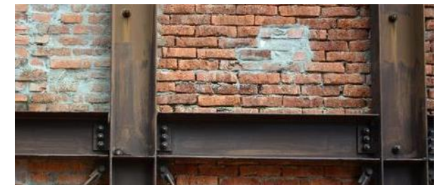
Εικ.164 :Ο μεταλλικός σκελετός πληρώνεται με τούβλα
