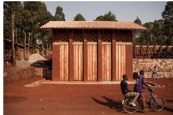
Εικ.205: Σύστημα περσίδων στην πρόσοψη
