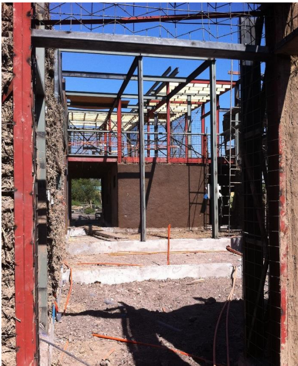
Εικ.188: Διακρίνεται ο μεταλλικός σκελετός όπου διαμορφώνεται στο εσωτερικό του πλέγμα το οποίο πληρώνεται με χώμα.
