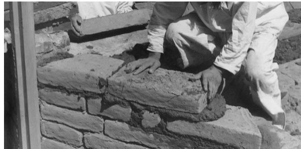
Εικ. 125: Τοποθέτηση τούβλων από ωμόπλινθο για την κατασκευή φέρουσας τοιχοποιίας
