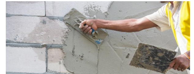
Εικ.163: Σοβάτισμα εξωτερικής τοιχοποιίας.
