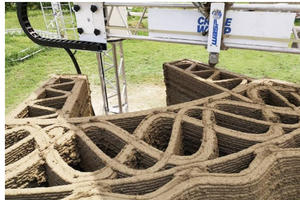
Εικ.121: Διαδικασία κατασκευής με 3D εκτυπωτή
