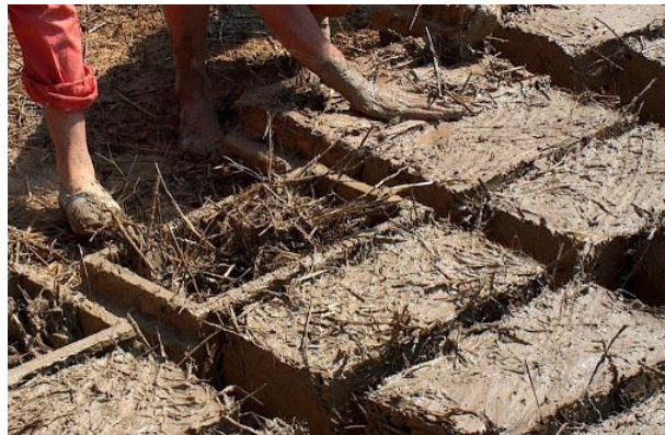
Εικ.96: Άχυρο ως πρόσθετο στοιχείο για ενίσχυση
