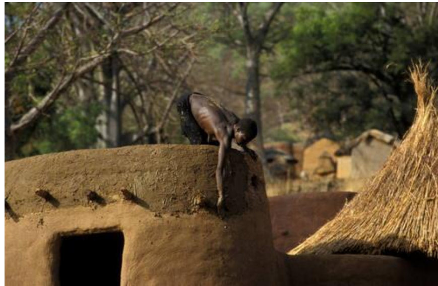
Εικ.31: Ανανέωση των όψεων με την χρήση πηλοκονιάματος
