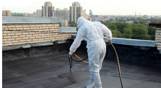
Εικ.160: Στεγάνωση οροφής
