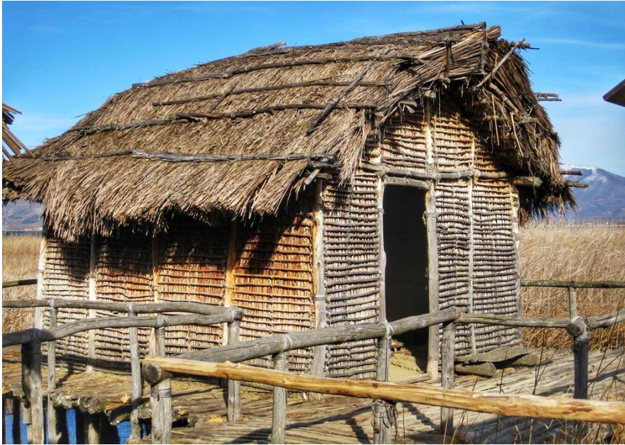
Εικ. 59: Διακρίνεται η φέρουσα κατασκευή και το πλέγμα από κλαδιά και καλάμια στο εσωτερικό χωρίς την χωμάτινη πλήρωση.
