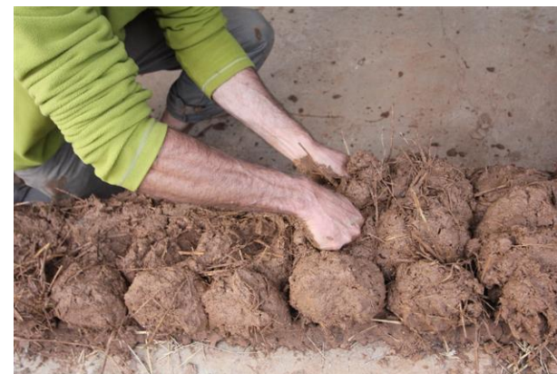
Εικ.83: Τοποθέτηση σβόλων για κατασκευή τοιχοποιίας και λείανση της στρώσης
