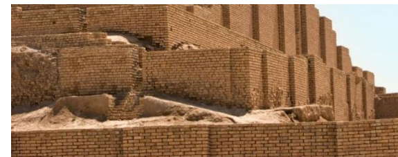
Εικ.2: Τεχνική κατασκευής με ωμόπλινθο στην Μεσοποταμία,
