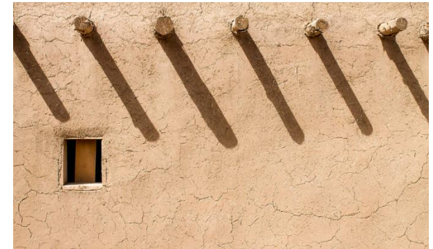
Εικ. 62: Διακρίνεται το μικρό άνοιγμα καθώς και οι ξύλινοι δοκοί τις οροφής
