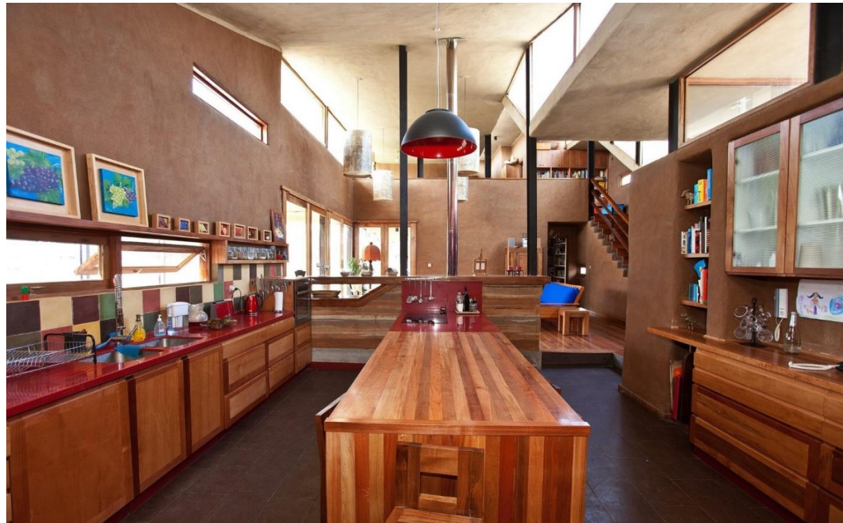
Εικ.200: Οι φεγγίτες επιτυγχάνουν επαρκή φωτισμό στο εσωτερικό της κατοικίας.
