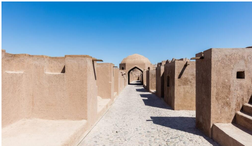
Εικ. 43: Φαίνονται οι θολωτές στέγες και το τοξωτό άνοιγμα που οδηγεί στο παζάρι της πόλης
