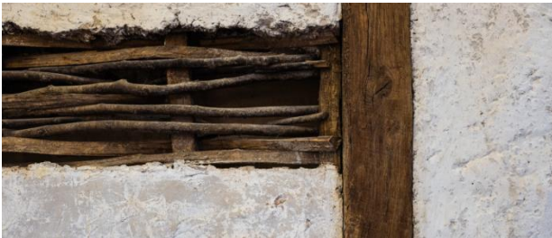
Εικ.105: Τοιχοποιία με την τεχνική Wattle and daub, διακρίνεται ο ξύλινος σκελετός καθώς και το πλέγμα που δημιουργείται με τα κλαδιά και τα καλάμια
