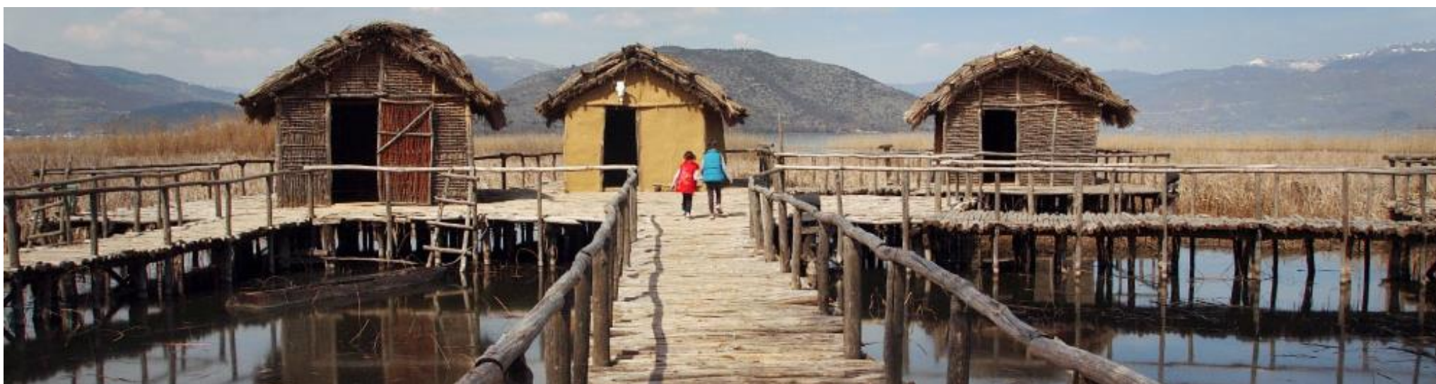
Εικ. 58: Οι καλύβες εδράζονται πάνω σε πασσαλόπηκτες ξύλινες έδρες στην λίμνη. Στο κέντρο είναι μια ολοκληρωμένη καλύβα με την τεχνική της πλήρωσης σε σχέση με τις άλλες δυο δεξιά και αριστερά όπου είναι ο σκελετός και ενδιάμεσα το πλέγμα από τα κλαδιά και τα καλάμια.
