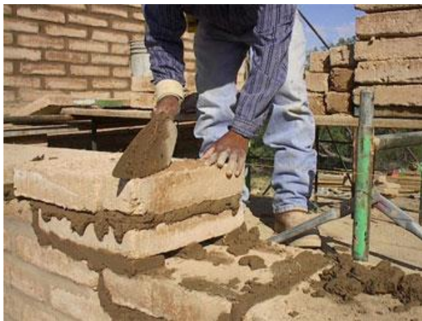
Εικ.138: Χρήση κονιάματος για σύνδεση των ωμόπλινθών τούβλων
