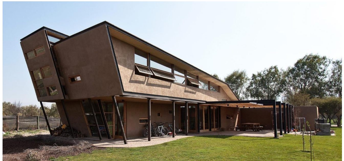
Εικ.187: Casa Munita Gonzalez, όπου διακρίνεται ο μεταλλικός σκελετός και οι γήινη τοίχοι
