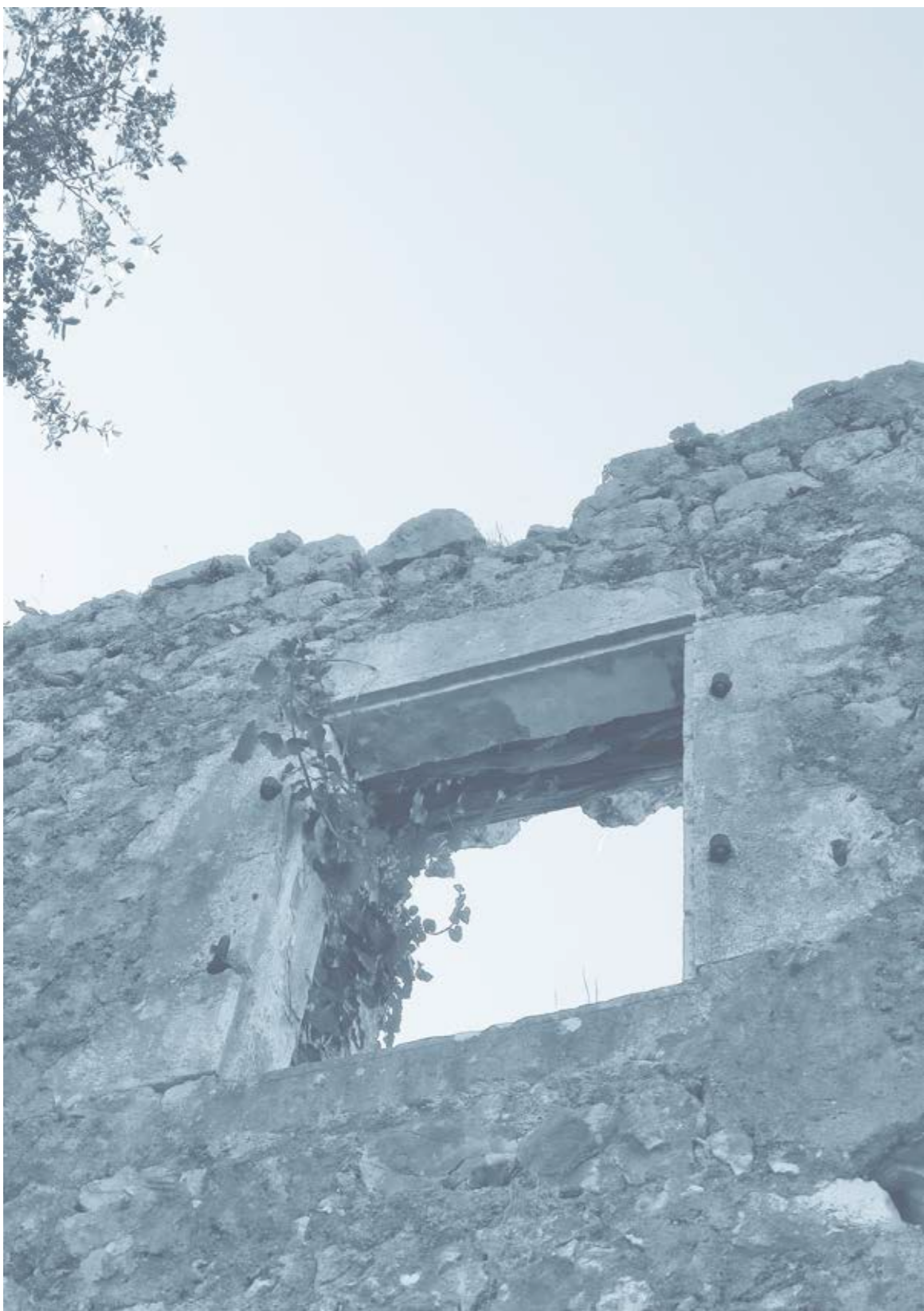
Εικόνα 1. Άνοιγμα σε κτίσμα του παλιού οικισμού των Καρυωτών Λευκάδας. Πηγή: Προσωπικό αρχείο
