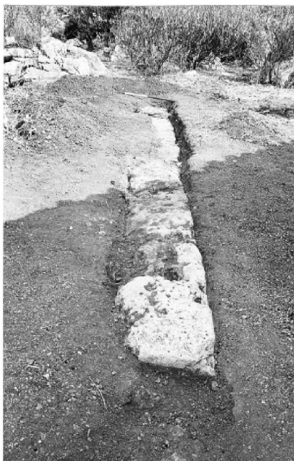
Εικ. 17. Κτίσμα Κ1. Πώρινη θεμελίωση.
