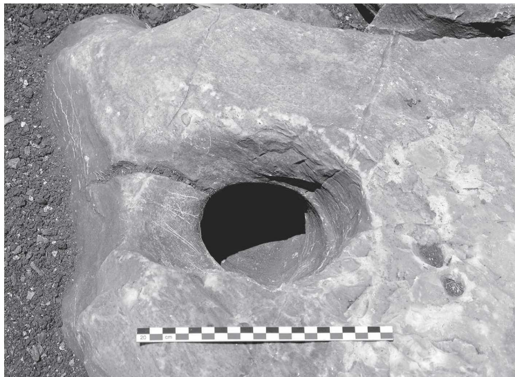
Εικ. 9. Οπή σε θεμέλια λιθόπλινθο του πύργου για την περισυλλογή του βρόχινου νερού της στέγης
