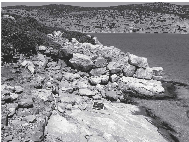
Εικ. 33. Η ογκολιθική κατασκευή Π8. Η λαξευμένη στον βράχο επικλινή αναβάθρα πιθανόν εξυπηρετούσε την ανέλκυση πλοιαρίων
