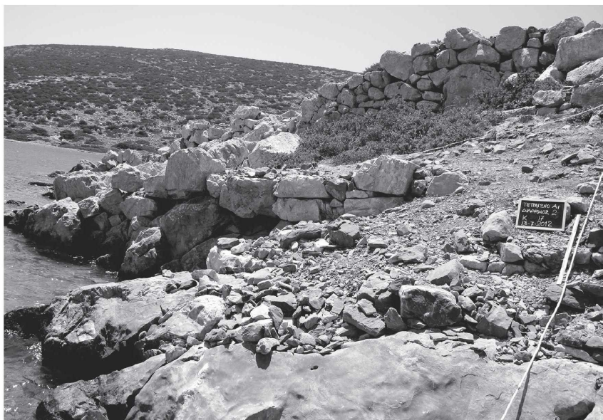
Εικ. 32. Η ογκολιθική κατασκευή Π6 όριζε ανηφορικό δρόμο από τη βορειο-ανατολική ακτή προς τα πάνω της ακρόπολης. Πίσω της διακρίνεται το ισχυρό ογκολιθικό ανάλημμα
