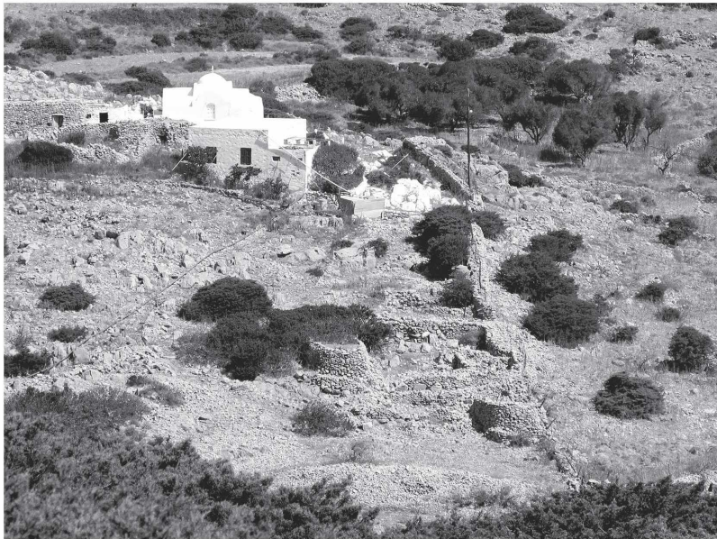
Εικ. 43. Ο βυζαντινός ναός του Αγίου Ιωάννη είναι οικοδομημένος επάνω σε λείψανα αρχαίων κτηρίων
