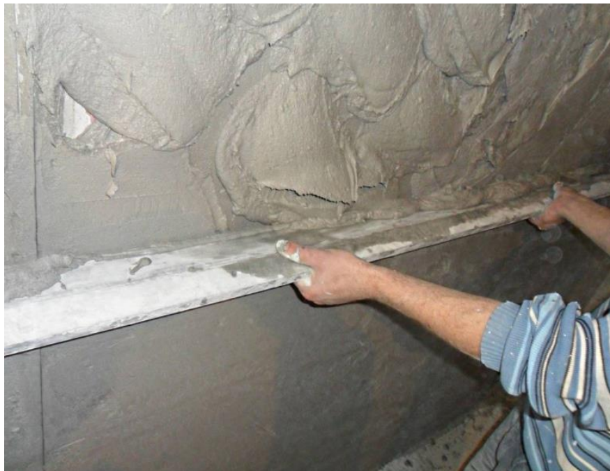
Εικόνα 10: Κονίαμα επιχρίσματος (σοβάς)
