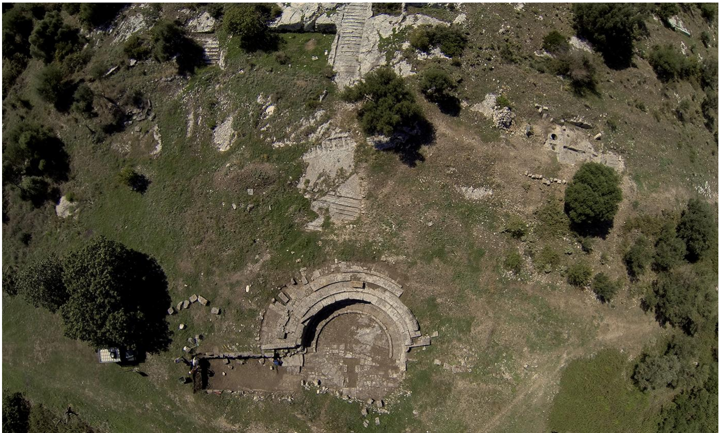
Εικόνα 193. Η ανατολική πλευρά του λόφου του Παλαιοκάστρου, με την κλιμακωτή οδό, λείψανα οικιών στα πλάγια και στο κάτω μέρος το Νυμφαίο της πόλης. https://octopusfoundation.org/
