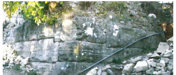
Εικόνα 170. Η α' οχυρωματική φάση της Ολύμπης (τέλη 5 ου - αρχές 4 ου αι. π.Χ.). Cabanes - Korkuti - Baçe - Ceka 2008, 214 αρ. 2.
