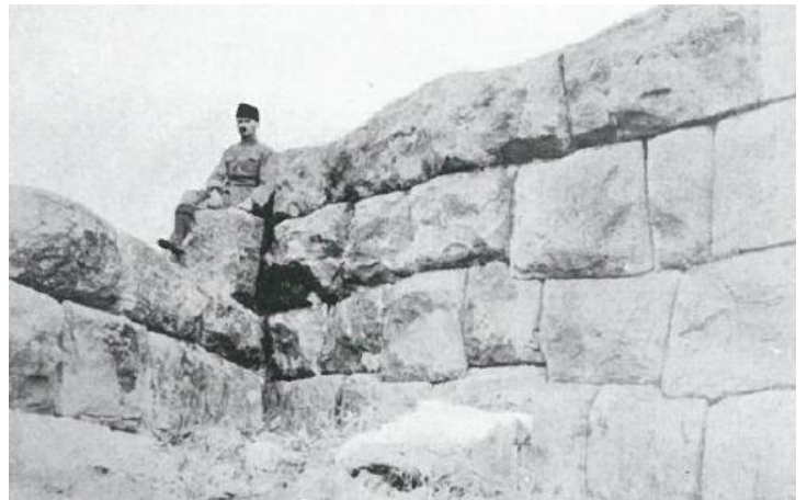
Εικόνα 25. Πολυγωνικό τείχος ανατολικής πλευράς. Cabanes - Korkuti - Baçe - Ceka 2008, 103 αρ. 4.
