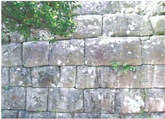
Εικόνα 241. Τμήμα της τραπεζοειδούς-πολυγωνικής οχύρωσης του Βουθρωτού, αρχές 4 ου αι. π.Χ. Cabanes - Korkuti - Baçe - Ceka 2008, 75 αρ. 5.
