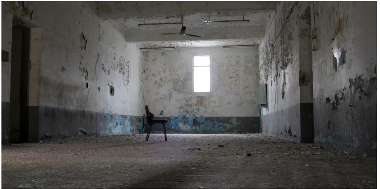
Το σημερινό φουαγιέ του μουσείου Τσιτσάνη στο κεντρικό κτήριο των φυλακών πριν την αποκατάσταση του
