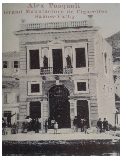
Εικόνα 9: Το εργοστάσιο τσιγάρων του Αλ. Πασχάλη στον Λιμένα Βαθέος (1901)
