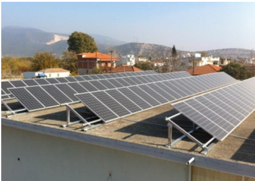
Εικόνα 5.7 Τοποθέτηση Φ/Β στοιχείων σε οροφή κτιρίου (πηγή: selasenergy)
