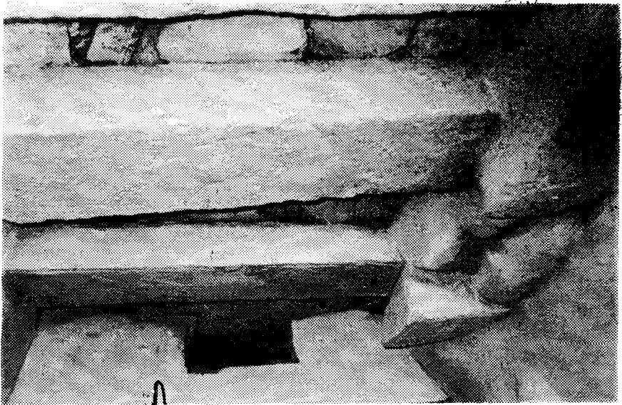
1. και 2. Λεπτομέρειες από την ανέγερση της εκκλησίας της Παναγίας στην Κολοφάνα
