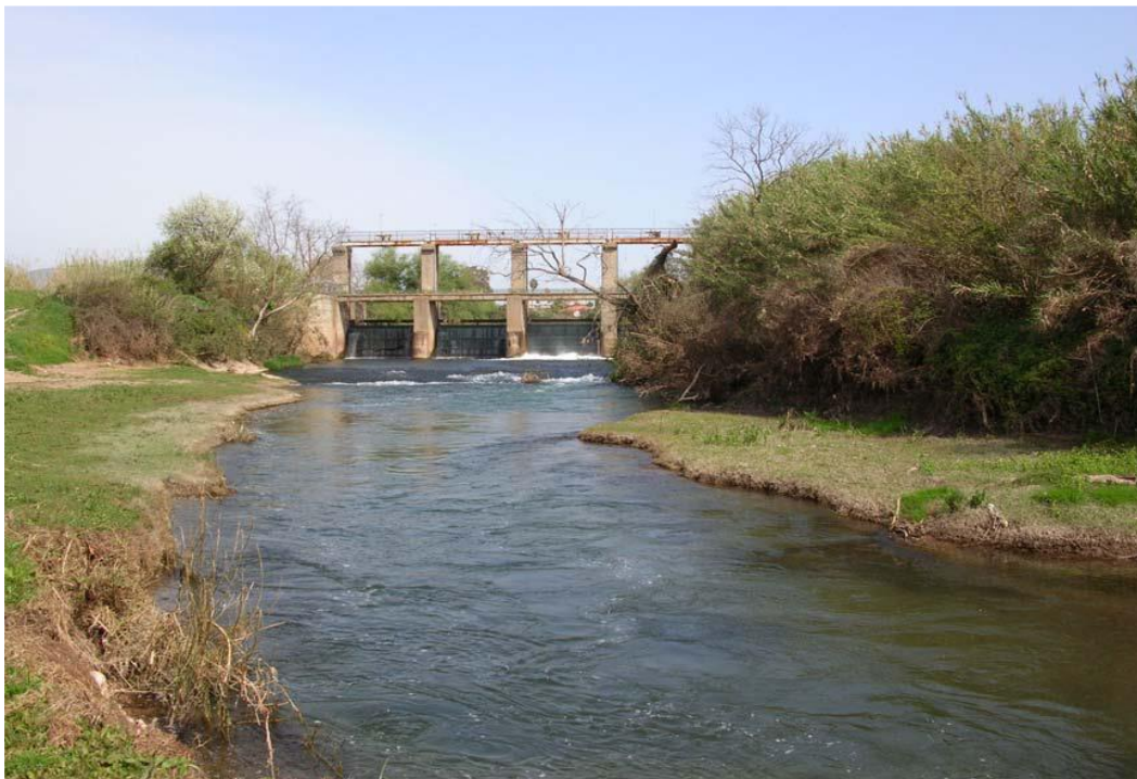
Εικόνα 4: Το φράγμα του Πάμισου
